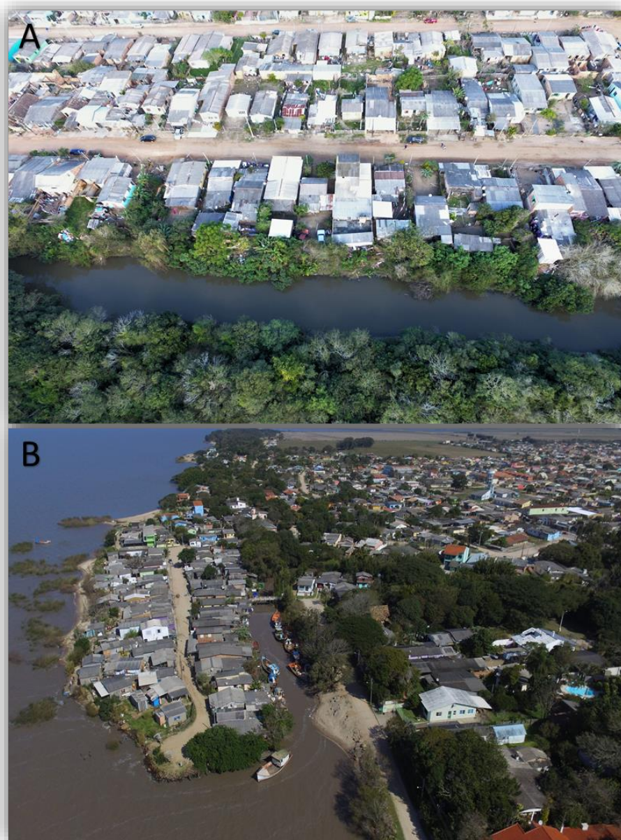
Figura 47 – Vista aérea das zonas urbanizadas em APPs, em (A) Arroio Teixeira e (B) Vila dos Pescadores, Tapes (RS).
