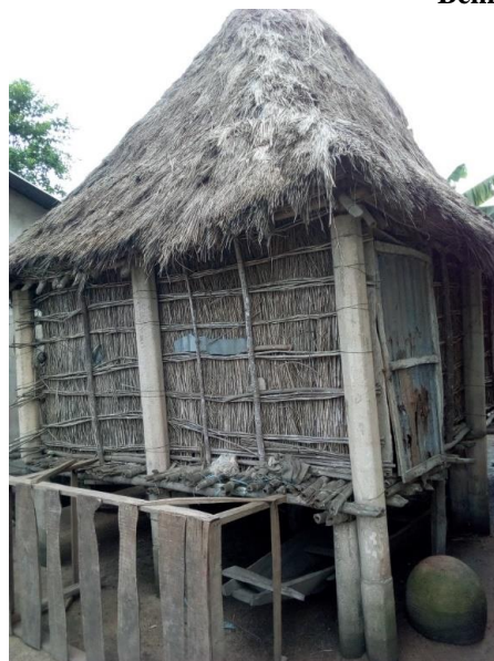
Figura 12 - Celeiro tradicional em madeira e em vegetais de um produtor de milho de Azowlisse em Benim
