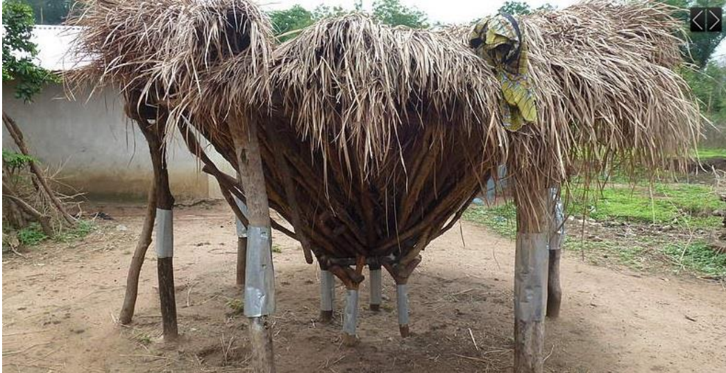
Figura 15 - Modelo de celeiro de madeira melhorado a base de matérias vegetais usado no norte de Benim
