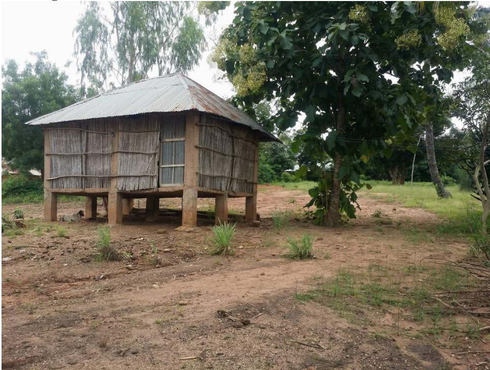
Figura 17 - Modelo de celeiro em madeira melhorado usado no sul de Benim
