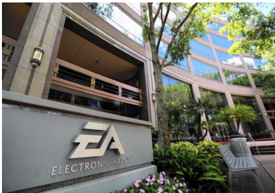
Figura 3 – Escritório da Electronic Arts em Maitland, Florida - EUA
