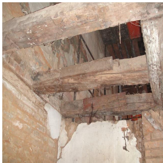
Figura 65 – Parte do vigamento na edificação
