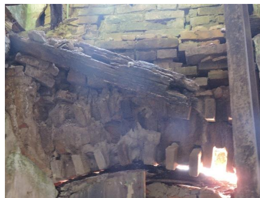
Figura 60 – Parte inferior da face interna esquerda da parede da fachada registro realizado antes da vistoria
