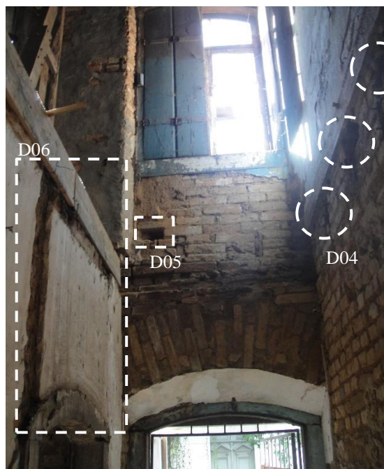
Figura 47 – Registro realizado de dentro da edificação para a porta de entrada da edificação
