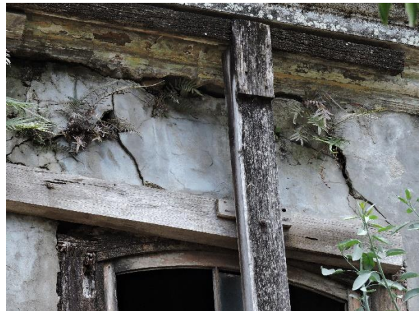
Figura 38 – Madeira do pórtico
