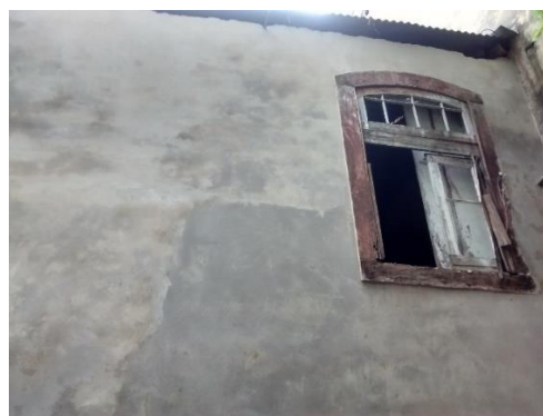
Figura 83 – Face externa da parede 6
