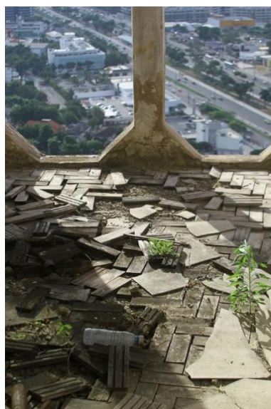
Figura 6 – Vista do interior da Torre H, em um dos apartamentos
