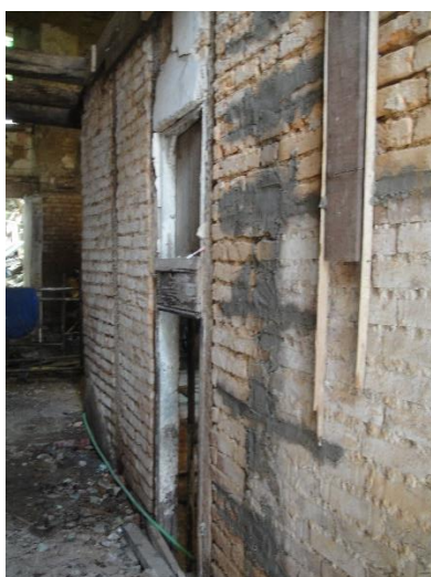
Figura 45 – Corredor de entrada da edificação, registro no sentido oposto à rua Riachuelo
