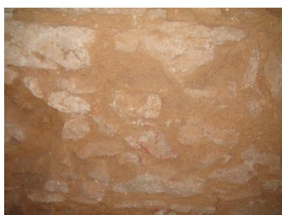
Figura 49 – Arenito utilizado como unidade de alvenaria nas paredes de divisão entre a edificação e edificações vizinhas
