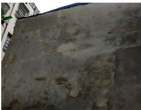
Figura 82 – Face externa da parede 6 vista dos fundos da casa
