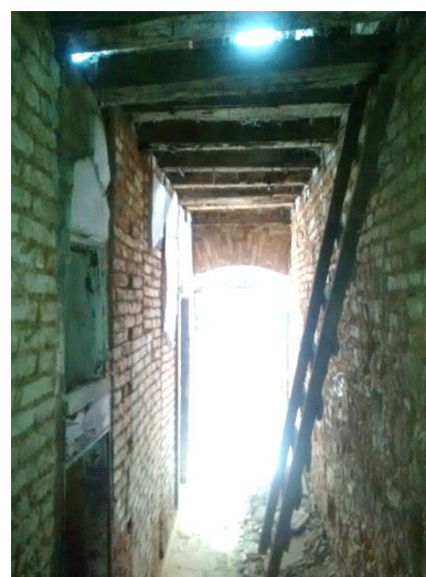
Figura 46 – Corredor de entrada da edificação, registro em sentido à rua Riachuelo
