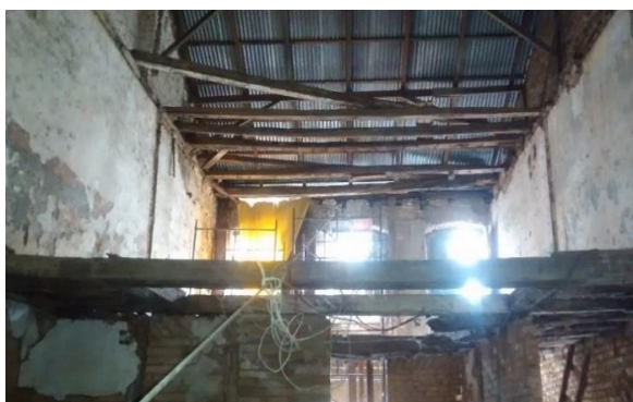
Figura 63 – Detalhe do vigamento da edificação
