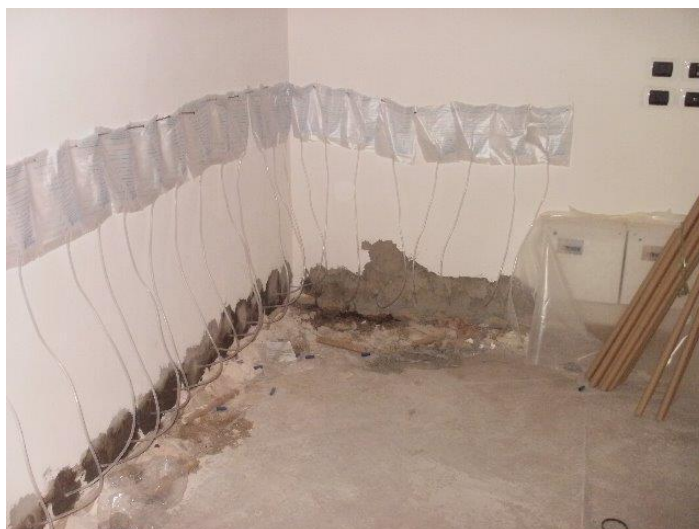
Figura 18 – Aplicação de substância para eliminar eflorescências
