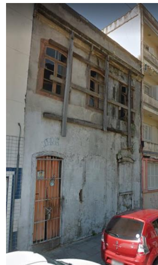
Figura 28 – Edificação em fevereiro de 2016
