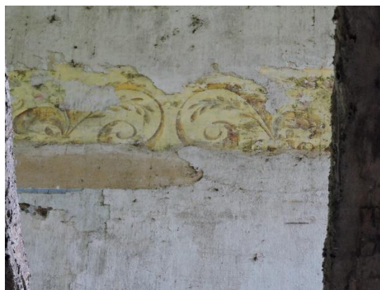
Figura 62 – Detalhes da pintura encontrada
