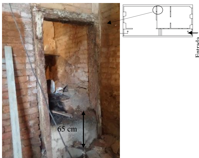
Figura 51 – Desnível entre os cômodos de entrada e o cômodo de fundos
