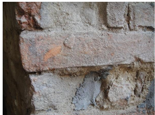
Figura 57 – Outra parte da parede onde foi aplicada argamassa de cimento
