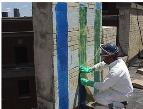
Figura 20 – Execução de reforço com resina e fibras
