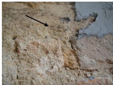
Figura 43 – Argamassa utilizada na alvenaria
