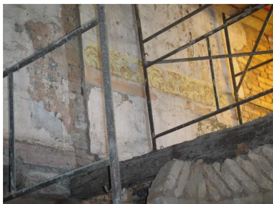
Figura 61 – Pinturas em amarelo na parede dois do cômodo em análise
