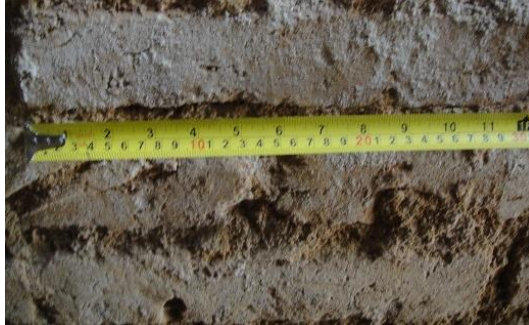
Figura 42 – Unidade de alvenaria da edificação
