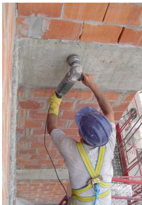
Figura 7 – Regularização do substrato com o uso de lixadeira
