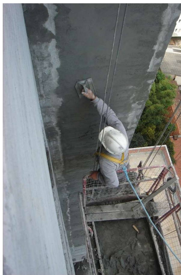
Figura 11 – Emboço sendo desempenado
