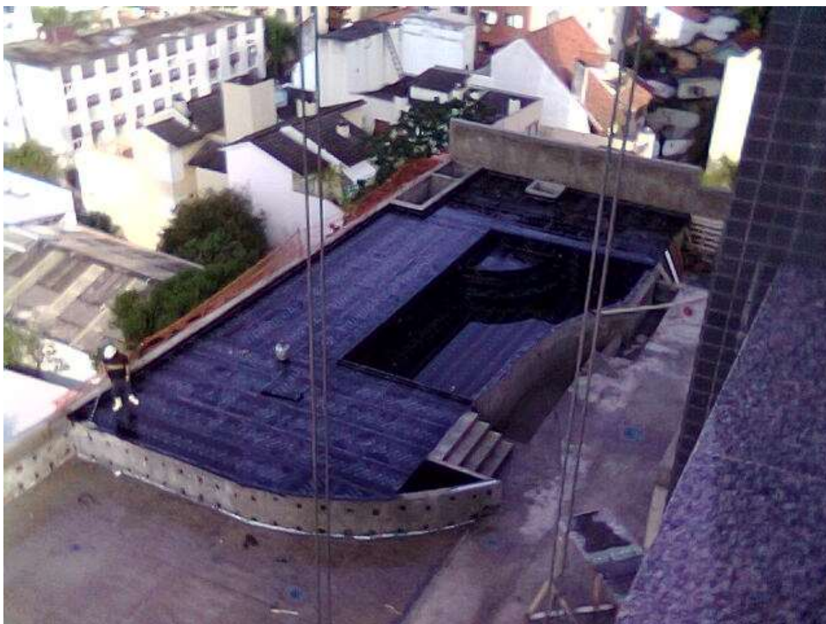
Figura 16 – Impermeabilização da piscina
