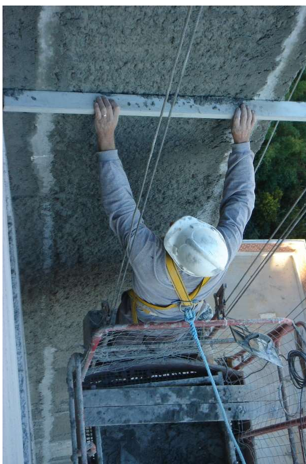
Figura 10 – Emboço sendo reguado
