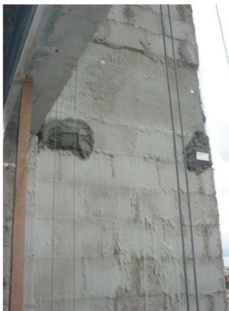
Figura 9 – Fixação das telas na fachada
