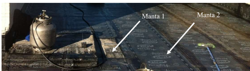
Figura 38 – Primeira e segunda mantas aplicadas na laje
