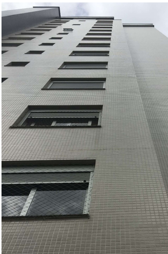
Figura 14 – Juntas de movimentação
