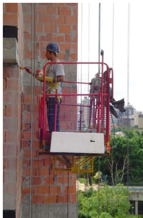
Figura 8 – Aplicação de zarcão em elementos metálicos
