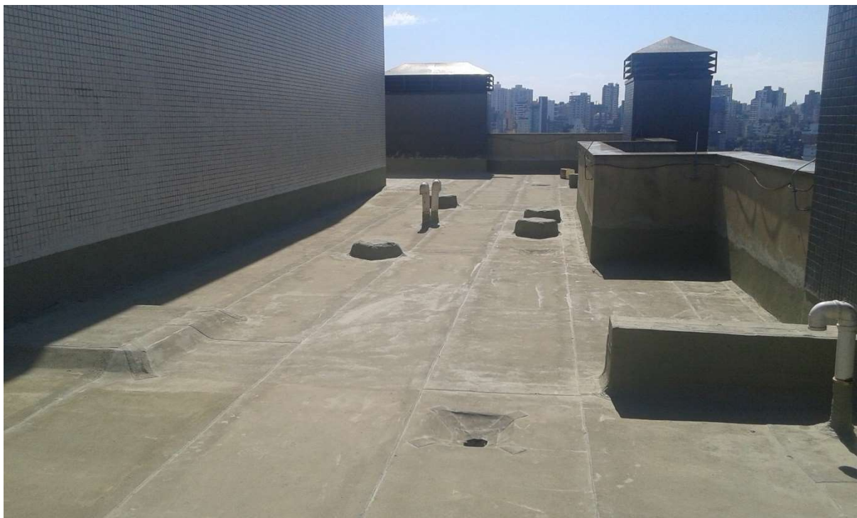
Figura 17 – Laje da cobertura
