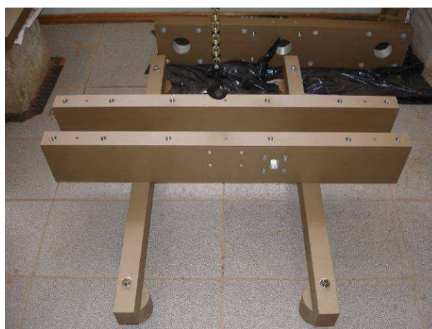
Figura 3.32 – Montagem das vigas inferiores
