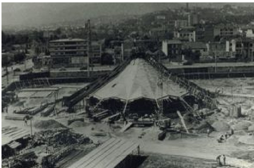
Figura 10 - Construção do Planetário
