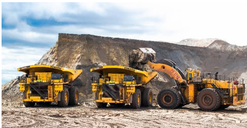
Figura 54 - Distância entre pá carregadeira para carregamento sequencial
