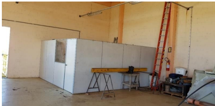
Figura 4.8 – Espaço improvisado como oficina (Foto do autor).
