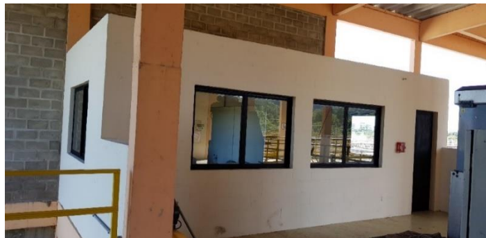
Figura 4.5 – Sala de operação da Desidratação (Foto do autor).
