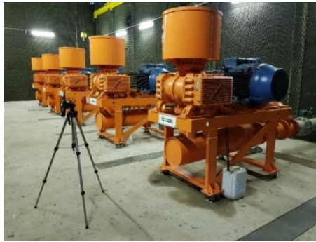
Figura 4.1 – Parte interna da casa dos Sopradores (Foto do autor).
