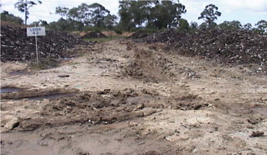
Figura 5: Estragos no pátio de compostagem.
