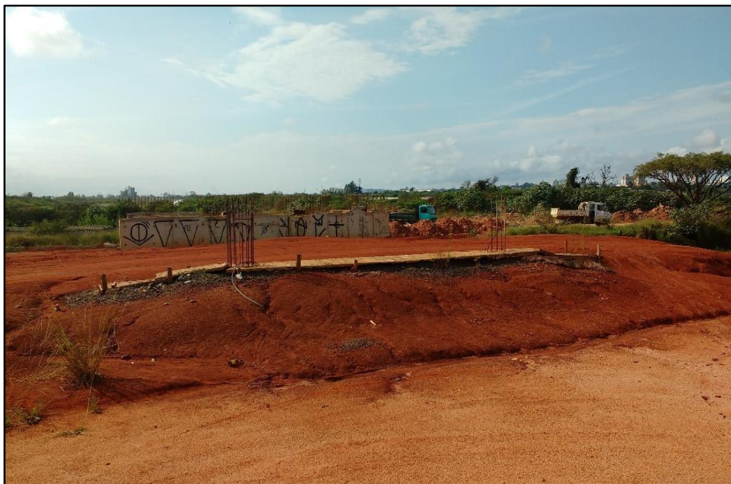
Figura 8. Obras de duplicação da Av. Severo Dullius.
