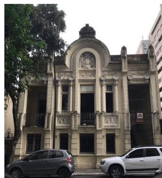
Figura 25 – Fachada do prédio Anexo ao MJC
