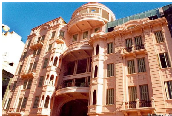
Figura 16 - Fachada da Casa de Cultura Mario Quintana
