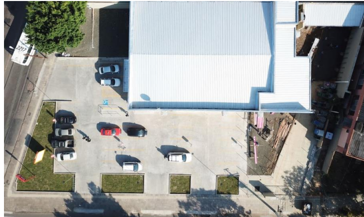
Figura 6 - Vista superior do empreendimento concluído
