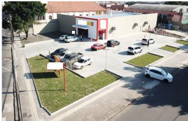
Figura 7 - Vista Frontal do empreendimento concluído
