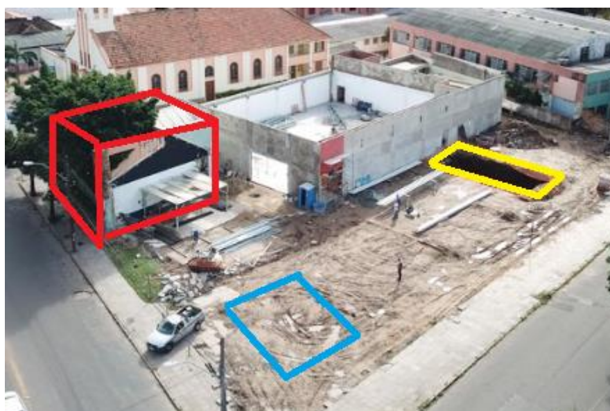
Figura 8 - Vista do canteiro de obras
