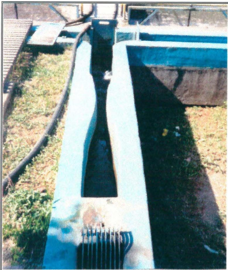
Figura 4.4 - Ponto de coleta de esgoto sanitário bruto, calha Parshall (ETE Arvoredo - DMAE)
