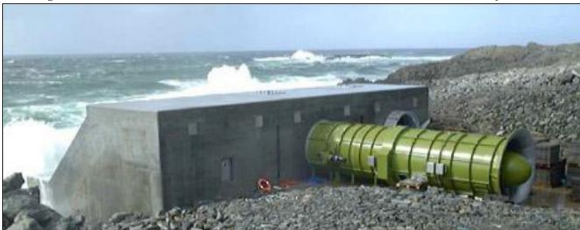
Figura 5 - Planta OWC LIMPET, 500 kW nominal, instalada no ano 2000 na ilha da Islay, Escócia.
