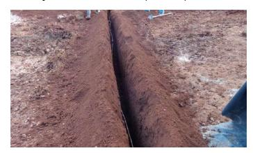
Figura 5 - Instalação dos condutores que compõem a malha de terra.
