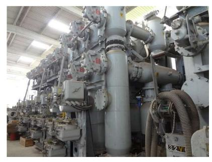
Figura 4 - Subestação à gás SF<sub>6</sub>.
