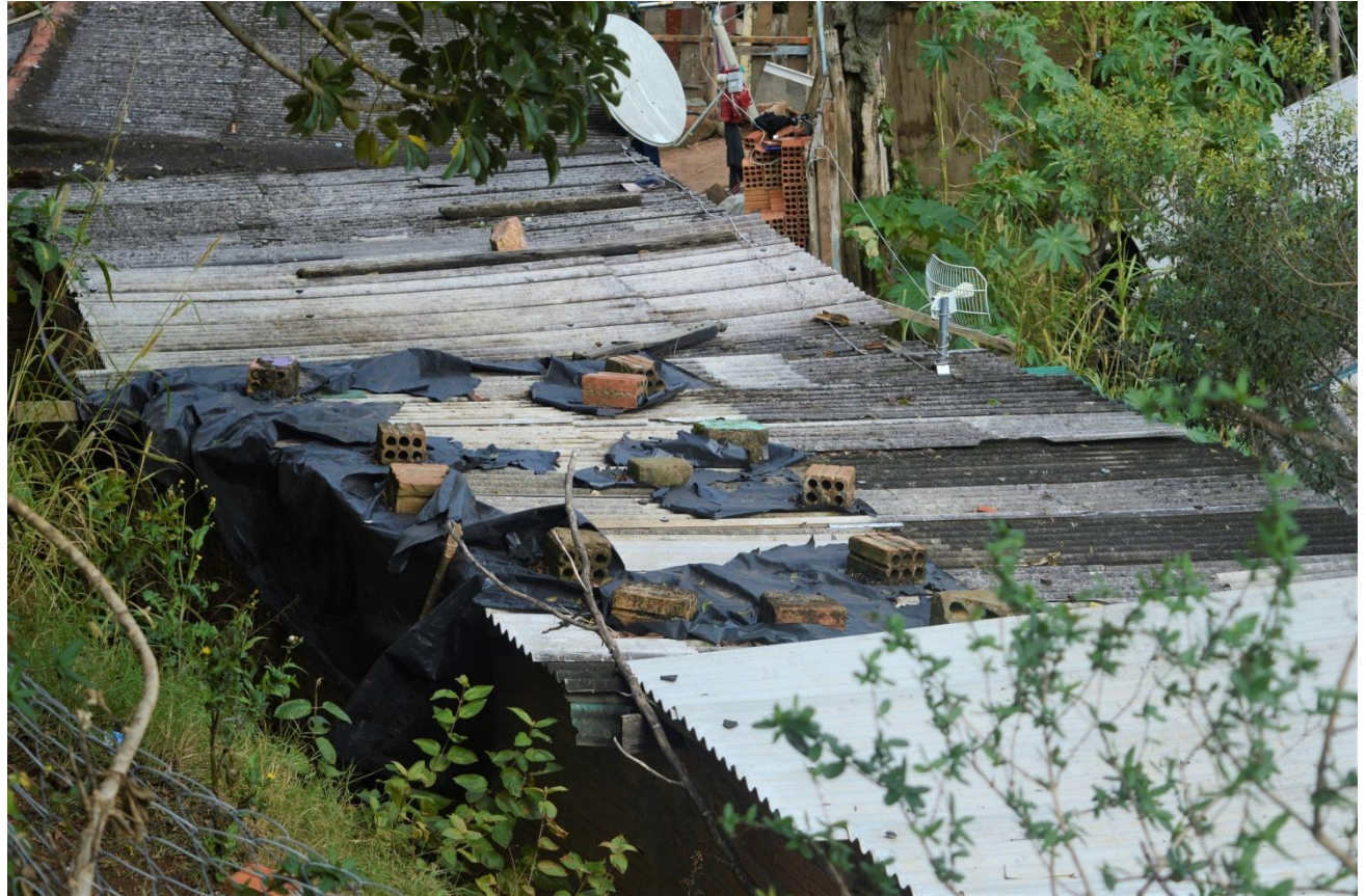
Figura 28: Leonardo Lopes. Registro de telhado, 2019.
