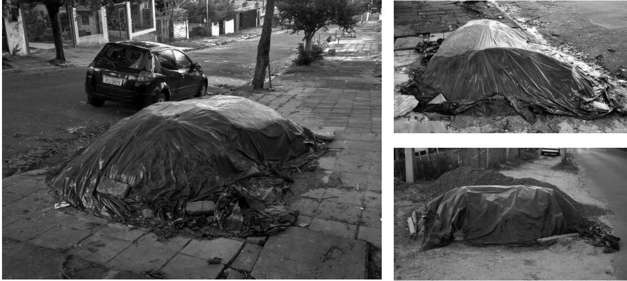
Figura 13: Registros de material de construção cobertos por lona preta, 2019.
