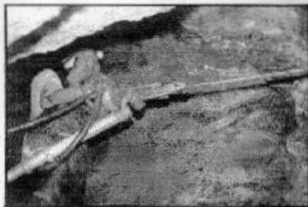
Figura 6 – Furação no bloco.
