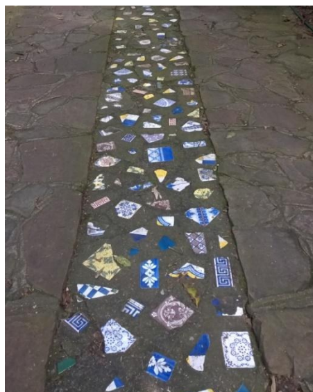
Figura 117: Detalhe do piso da rampa de entrada da Casa de Vidro. Fonte: foto da autora (2016).
