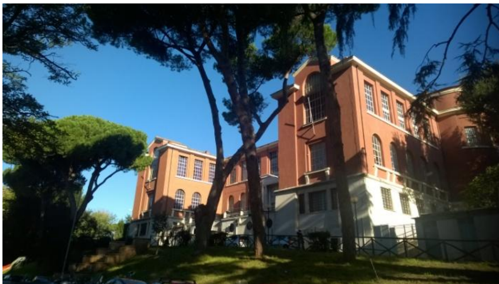
Figura 11: Edifício da Scuola Superiore di Architettura di Roma . Fonte: foto da autora, 2015.
