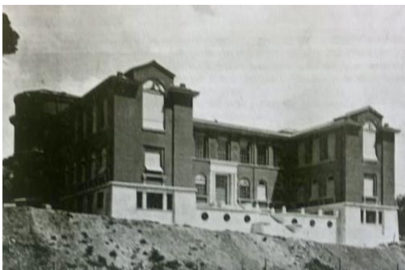
Figura 10: Edifício da Scuola Superiore di Architettura di Roma . Foto da época. Fonte: Giovannoni (1932, s/p).
