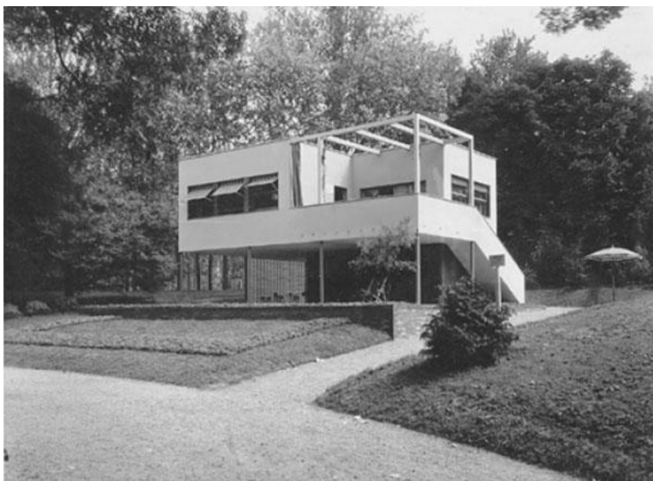
Figura 103: Casa de Férias Marítimas, na Trienal de 1933. Modelo construído. Apoios sobre tubos Mannesmann. Projeto de Griffini e Bottoni. Fonte: Savorra (2005, p. 121).
