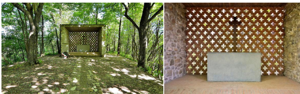
Figura 85: Monumento aos mortos de guerra. Ignazio Gardella. Situação atual. Observar elemento vazado, construído a partir do tijolo. Fonte: http://www.floornature.it/blog/la-cappella-di-varinella-di-ignazio-gardella-12923/# , acesso em março 2017.
