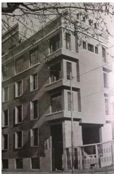
Figura 52: Edifício no Lungotevere Tor di Nona . Marcello Piacentini, 1929-1931. Fonte: Ciucci; Lux; Purini (2010, p.148).
