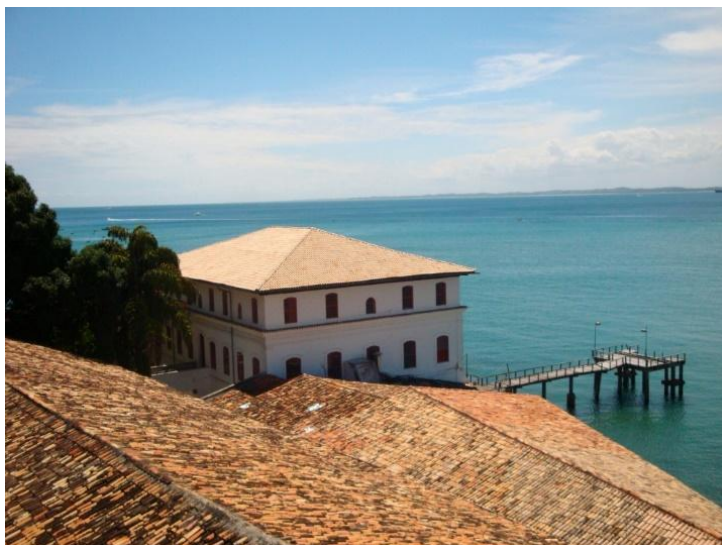
Figura 145: Conjunto Unhão. Intervenção de Lina Bo Bardi, 1959-1963. O caráter de similaridade do conjunto nas coberturas do solar e dos galpões, estes últimos com surgimento em momento diverso do solar. Fonte: foto da autora (2011).
