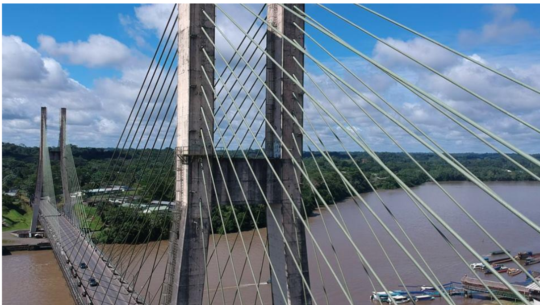
Figura 5: Ponte do Puerto de Francisco de Orellana (Ponte sobre o Rio Napo)
