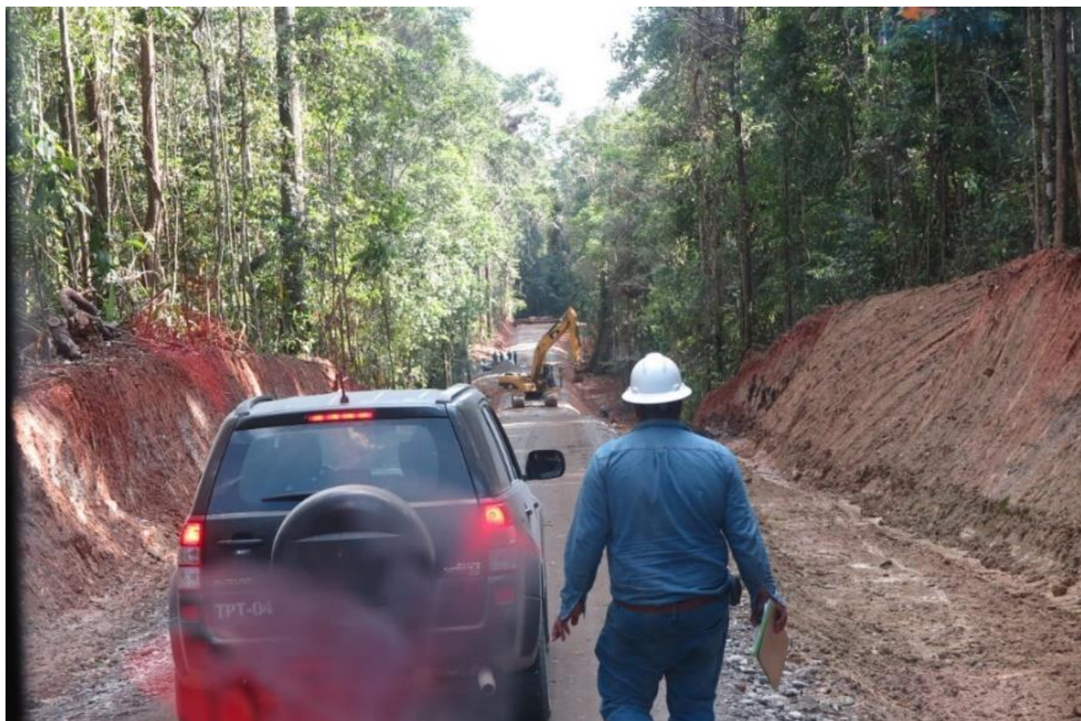
Figura 31: Construção de vias para exploração petroleira com lastro e areia
