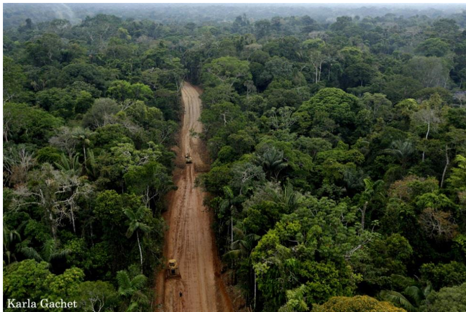
Figura 29: Via construída no bloco 31 ao lado do bloco 43 (bloco ITT)
