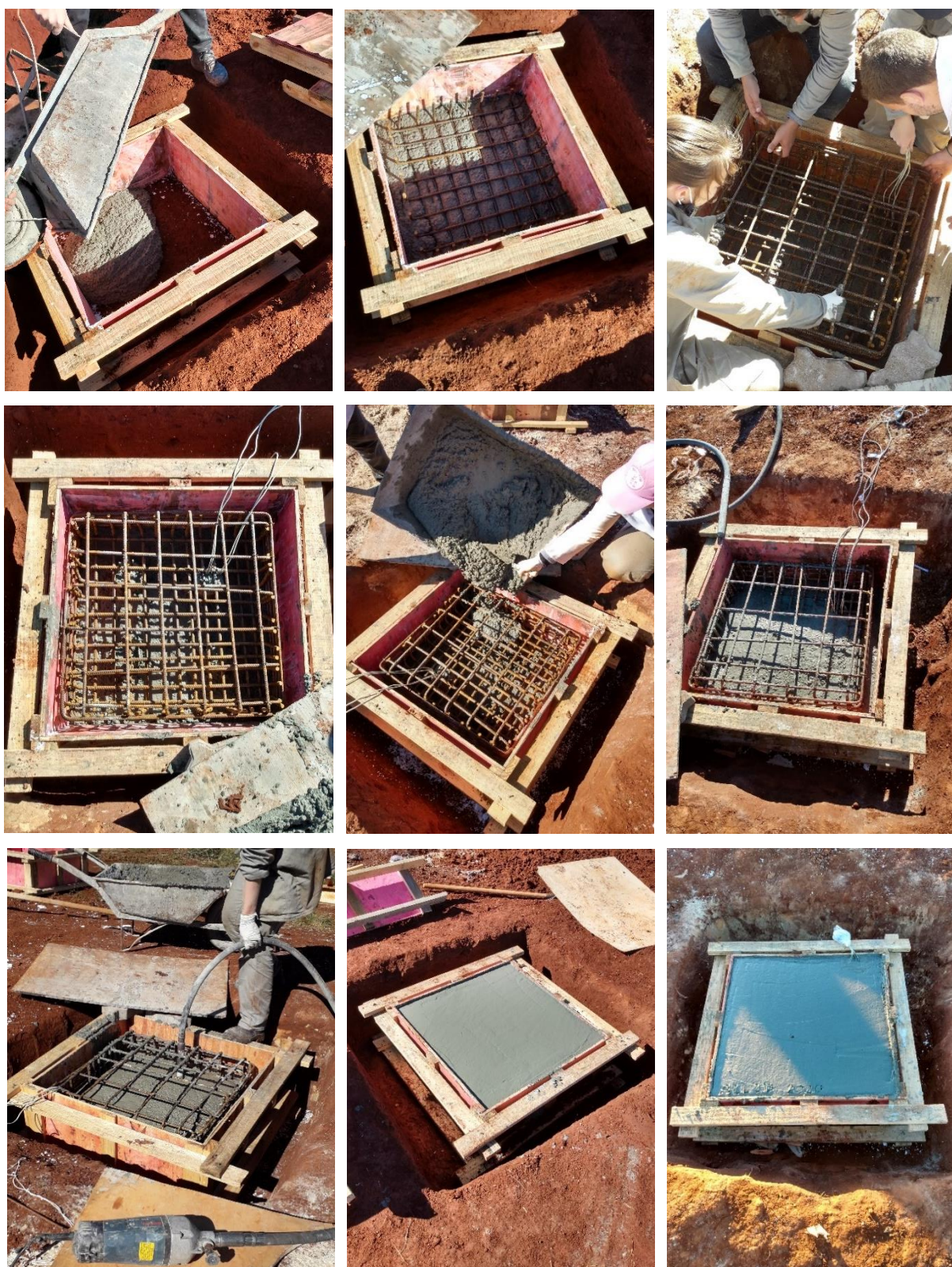
Figura 4.19: Concretagem das fundações com sapata
