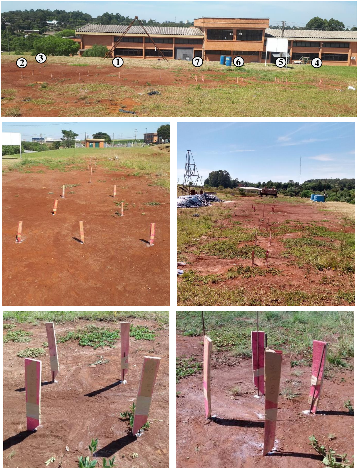
Figura 4.4: Locação das estacas em campo
