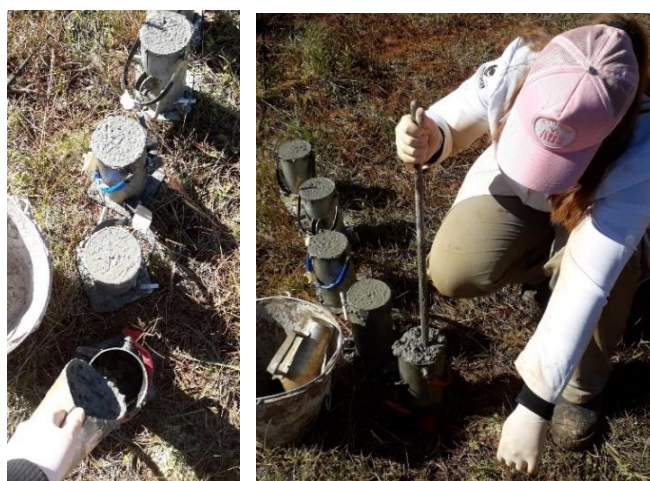
Figura 4.25: Moldagem dos CPs do concreto produzido em campo
