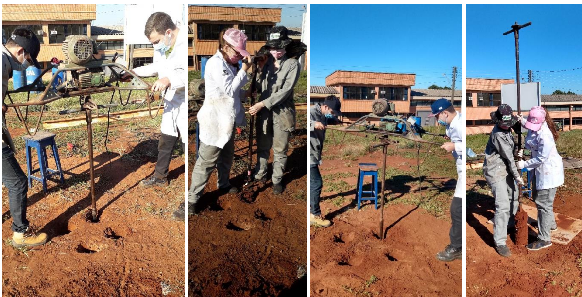
Figura 4.11: Escavação das estacas
