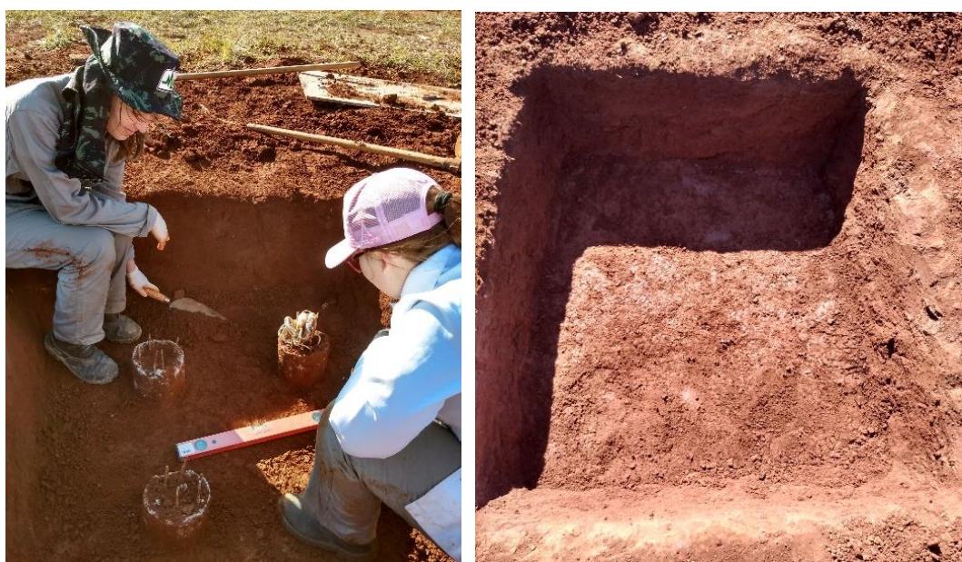
Figura 4.15: Regularização do solo para execução das sapatas
