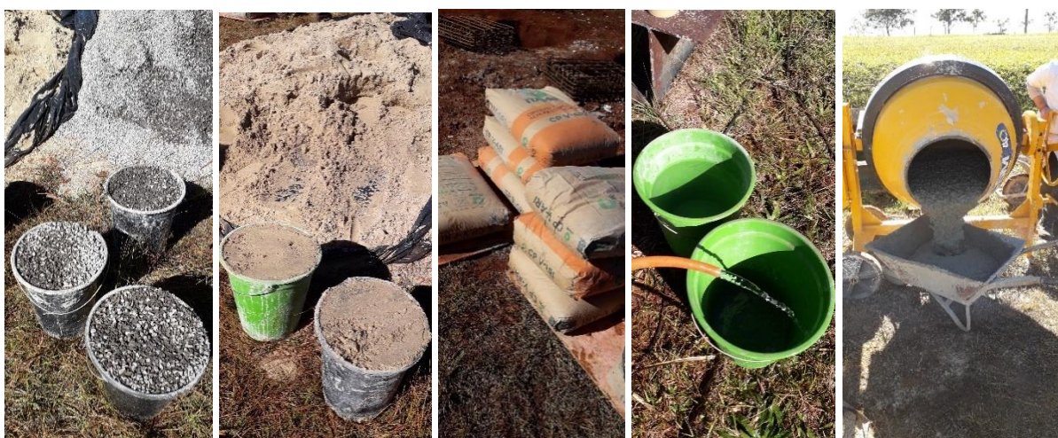
Figura 4.18: Confecção do concreto
