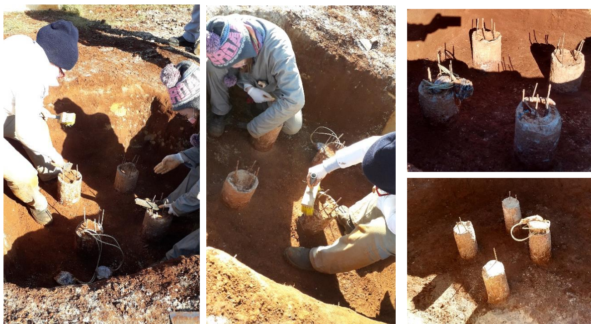
Figura 4.16: Limpeza do topo das estacas
