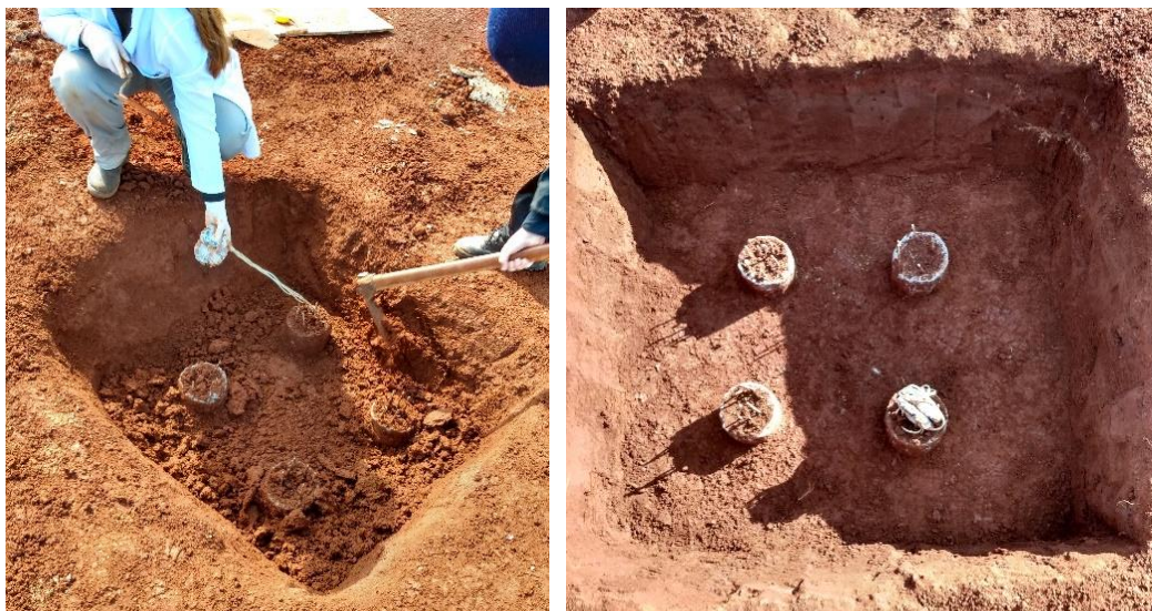
Figura 4.14: Escavação do solo para execução das sapatas
