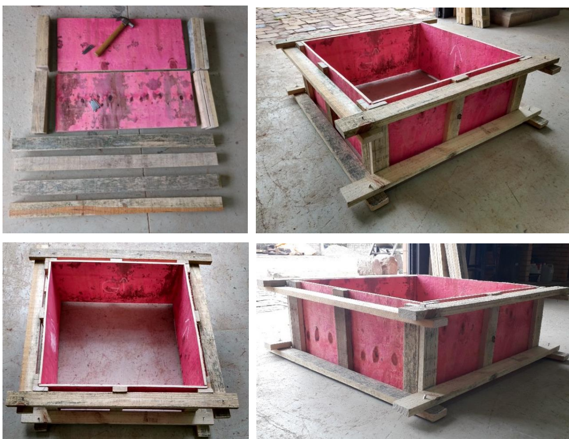
Figura 4.10: Montagem das formas
