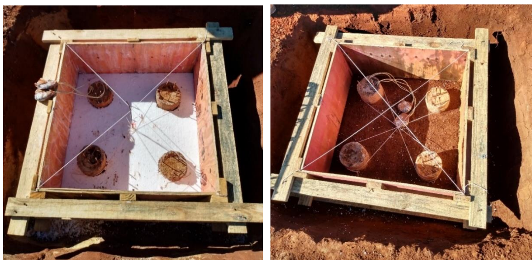
Figura 4.17: Posicionamento das formas no solo com e sem EPS
