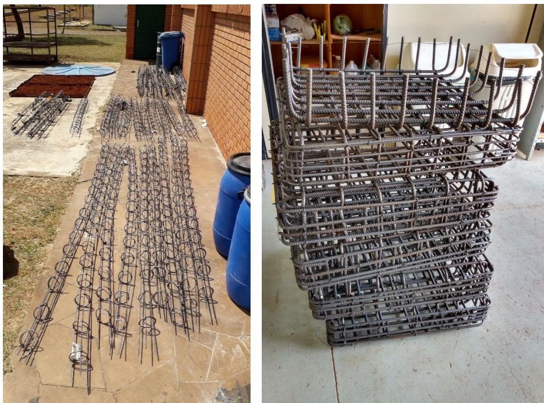
Figura 4.9: Armaduras preparadas
