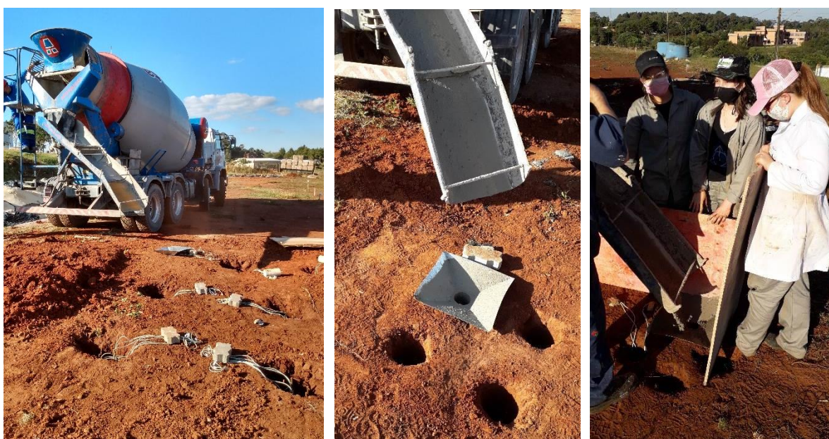
Figura 4.13: Concretagem das estacas
