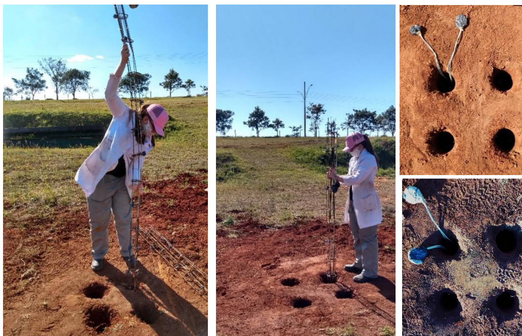
Figura 4.12: Posicionamento das armaduras nas estacas
