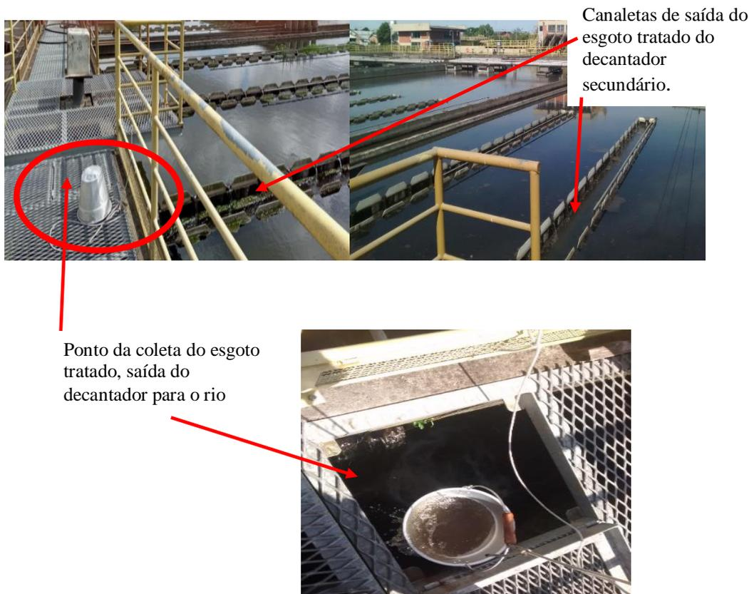
**Figura 4.** Vista geral da estação de tratamento de esgoto com lodo ativado, decantador secundário e local da coleta.
