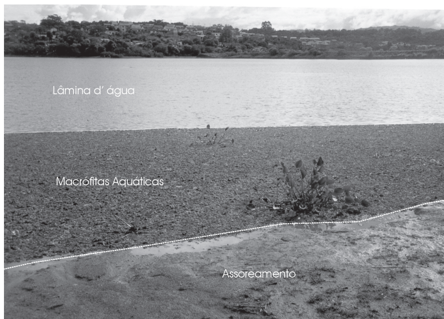
Figura 3. Fotografia da barragem Lomba do Sabão indicando área de assoreamento observada em primeiro plano, seguida de área com presença de macrófitas aquáticas (indicadoras de poluição da água) e ao fundo a lâmina d' água.
