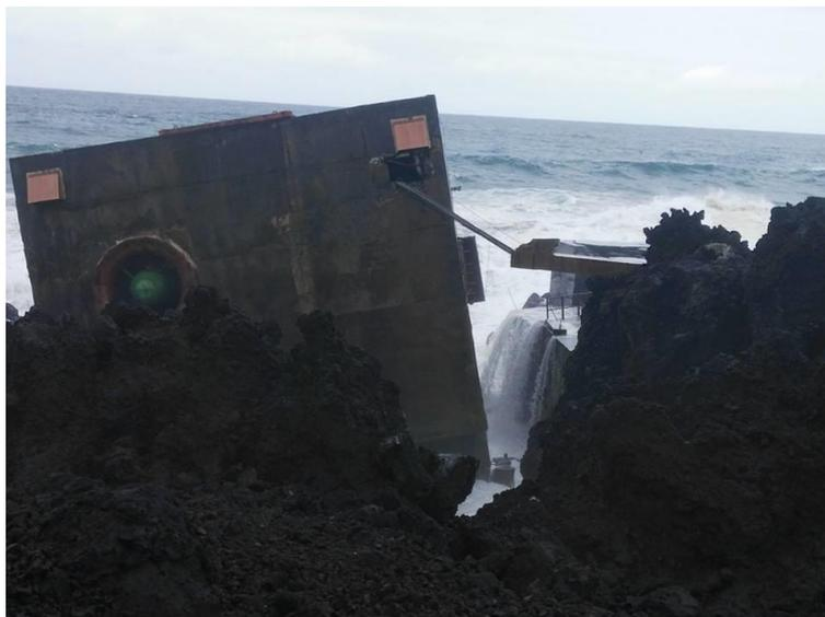
**Figura 8** – A COP após o colapso parcial da estrutura de fundação que ocorreu em 17 de abril de 2018.
