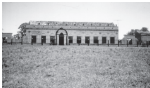
Estância do Seival, em Canguçu, com platibandas coroadas por urnas, cornija, pilastras e portões laterais.
