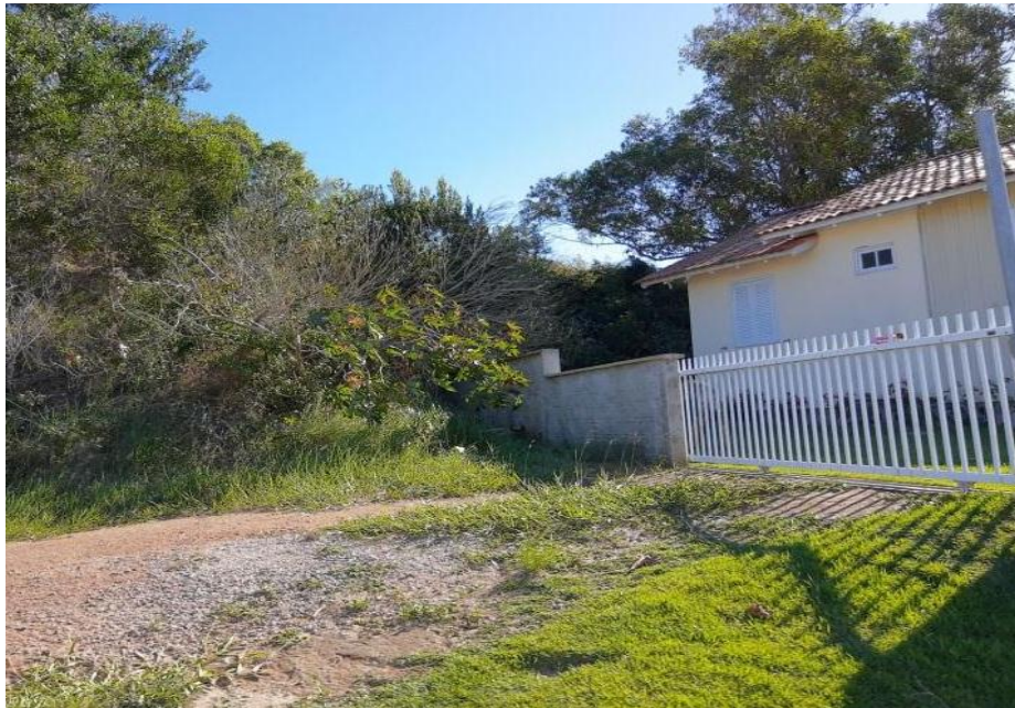
Figura 15 Residência construída nas proximidades de área de dunas
