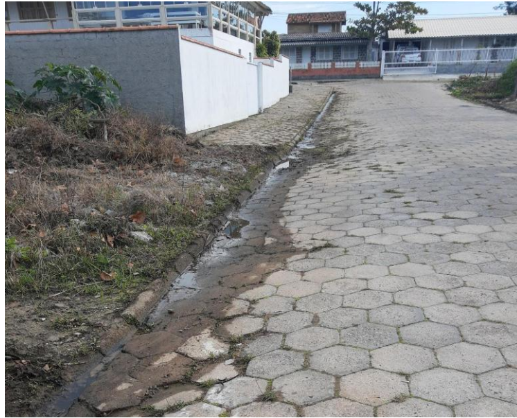
Figura 18 Presença de nascente no Loteamento Cascata Vermelha
