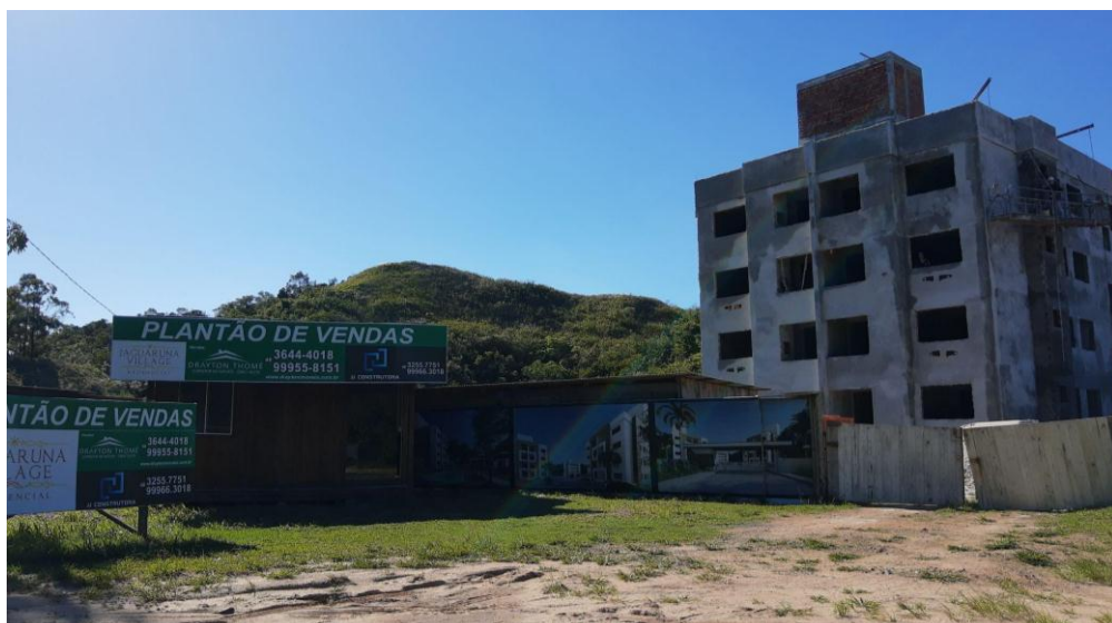
Figura 17 Construção de empreendimento multifamiliar nas proximidades da Lagoa
