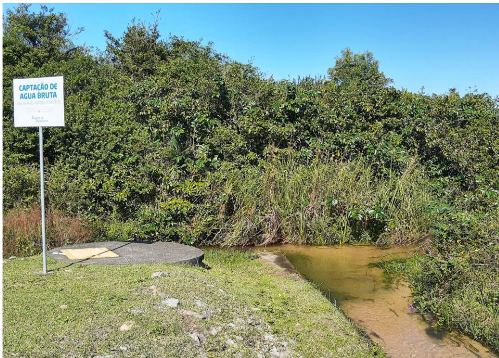
Figura 20 Captação de água nas margens da rodovia SC-442
