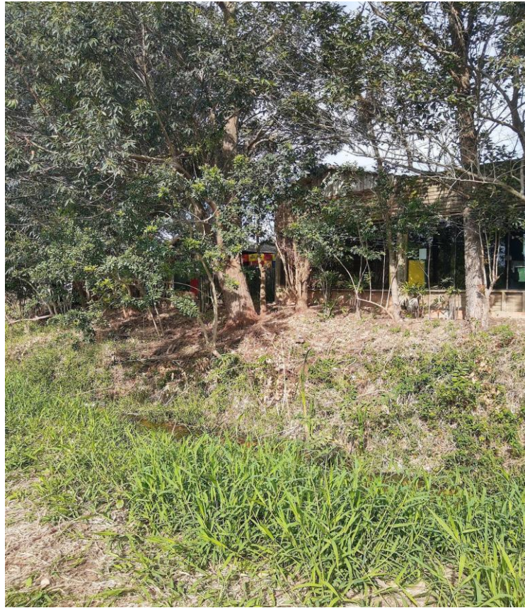
Figura 22 Estabelecimento comercial junto ao canal do Arroio Corrente
