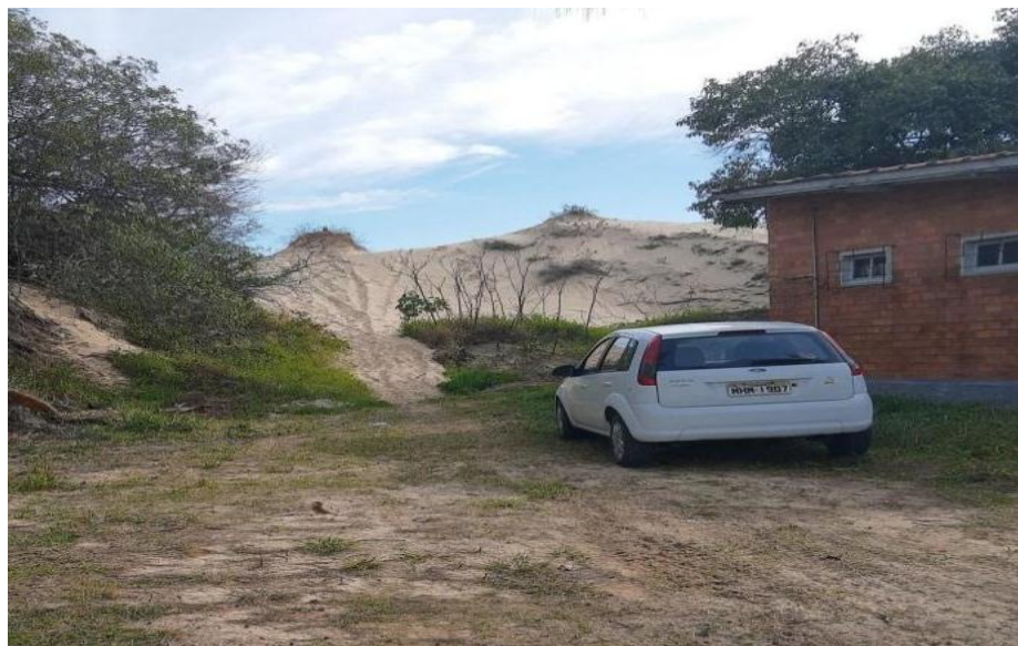
Figura 16 Residência construída em área de dunas no Loteamento Cascata Vermelha
