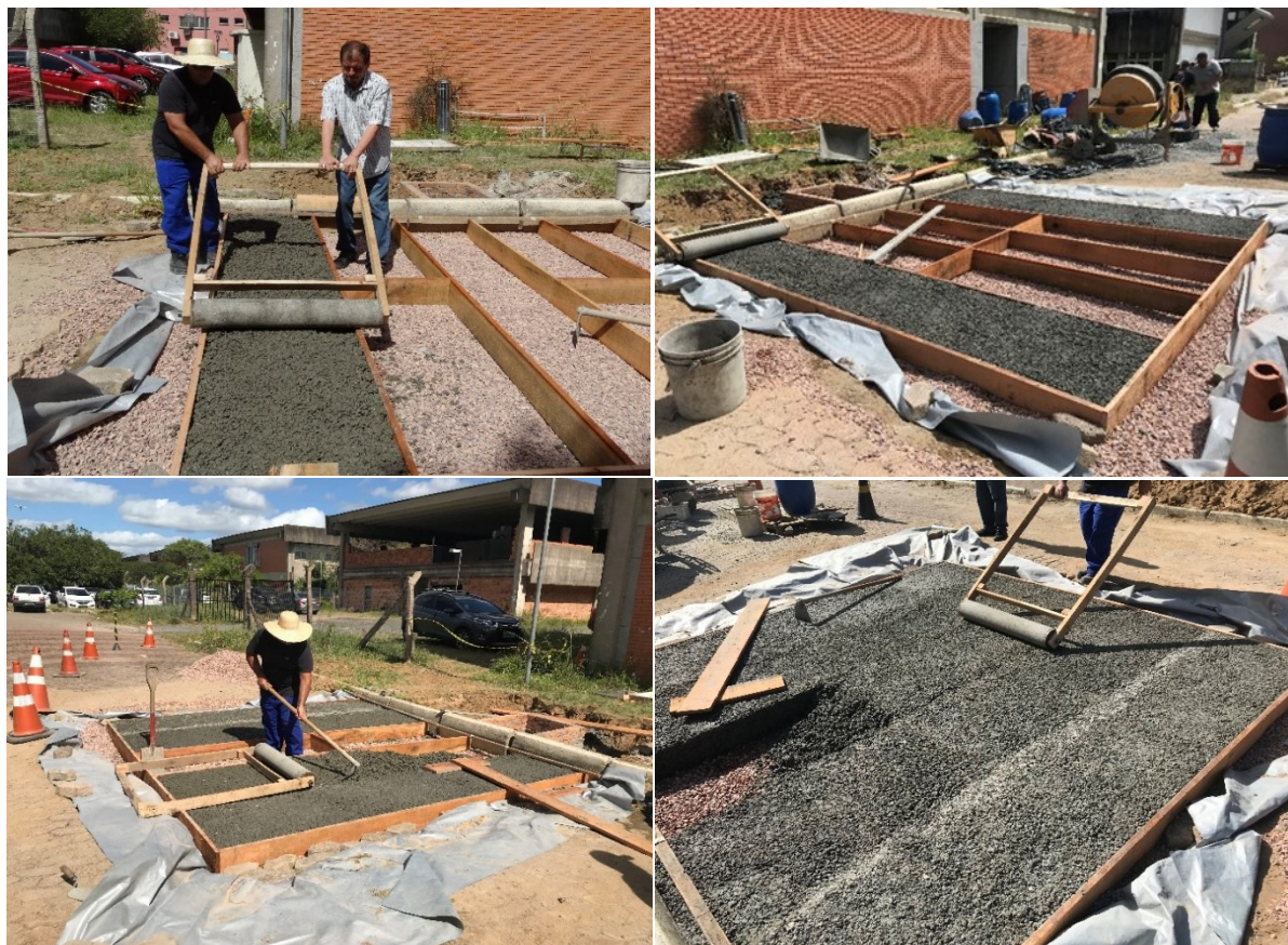
Figura 59. Execução do revestimento de concreto permeável
