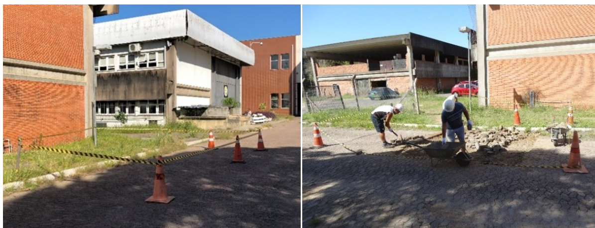
Figura 53. Sinalização e limpeza do local da obra
