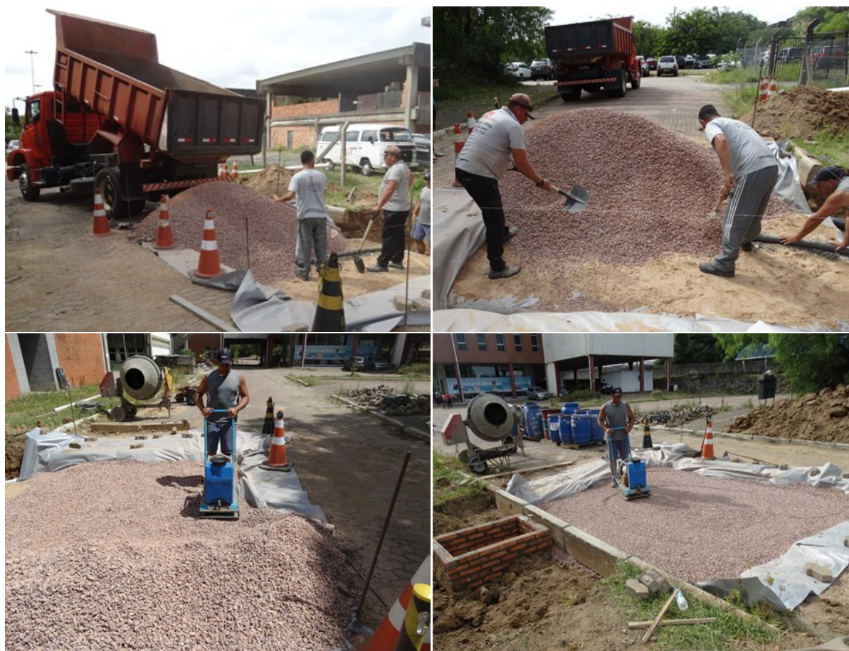
Figura 57. Execução da camada granular
