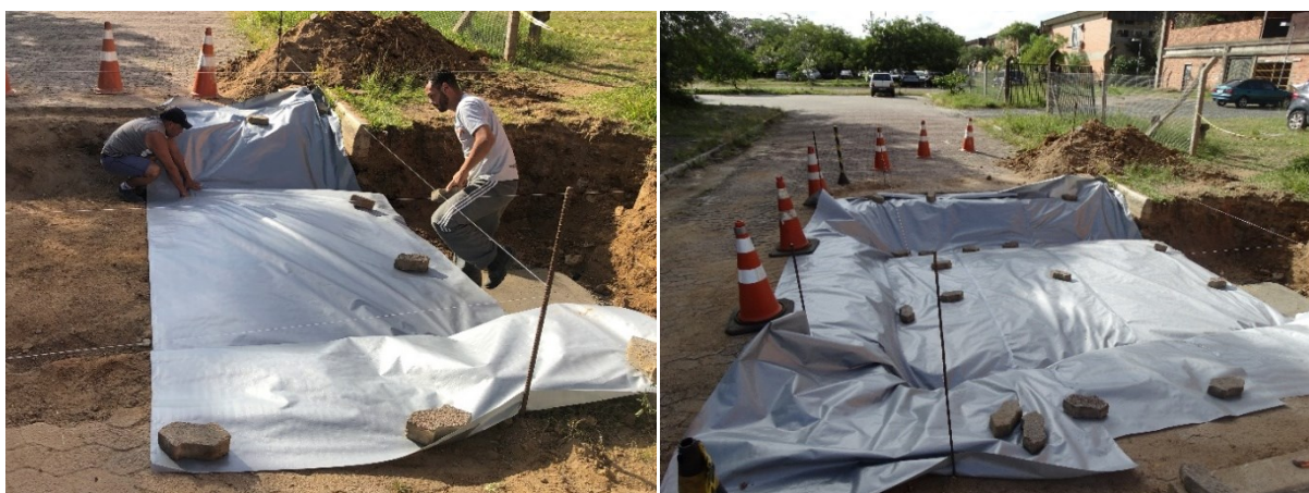
Figura 55. Instalação da manta sobre o subleito
