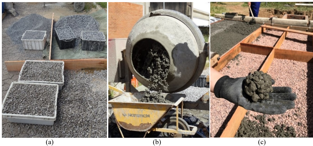
Figura 58. Dosagem e mistura: (a) dosagem em volume; (b) mistura em betoneiras e (c) controle da consistência
