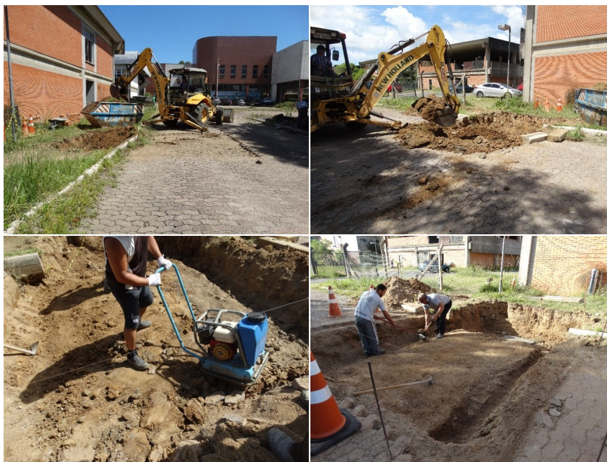
Figura 54. Serviços de escavação e compactação do subleito
