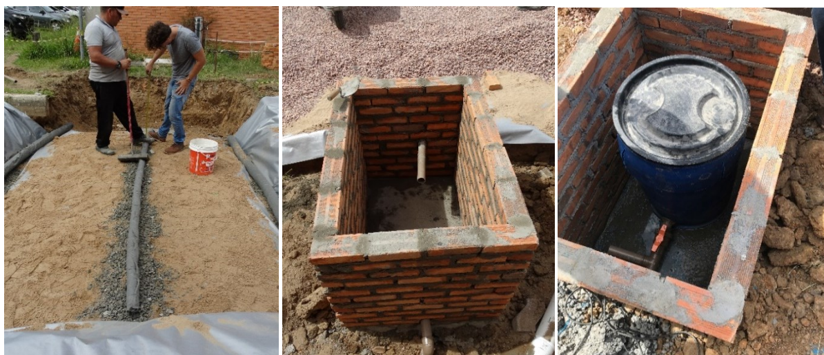
Figura 56. Sistema de drenagem e coleta de água
