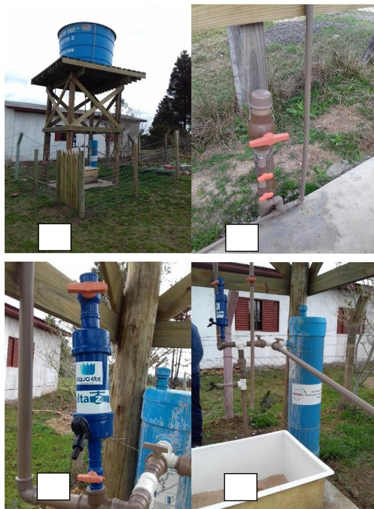
**Figura 4 - A) Sistema Salta-Z; B) Clorador de pastilhas; C) Dosador de coagulante; D) filtro Zeólita Salta-Z.**
