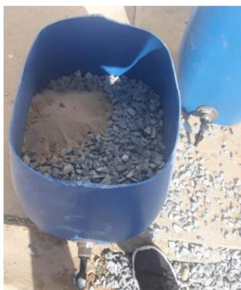
**Figura 6: Camada de brita nº 1 e pó de pedra peneirado**
