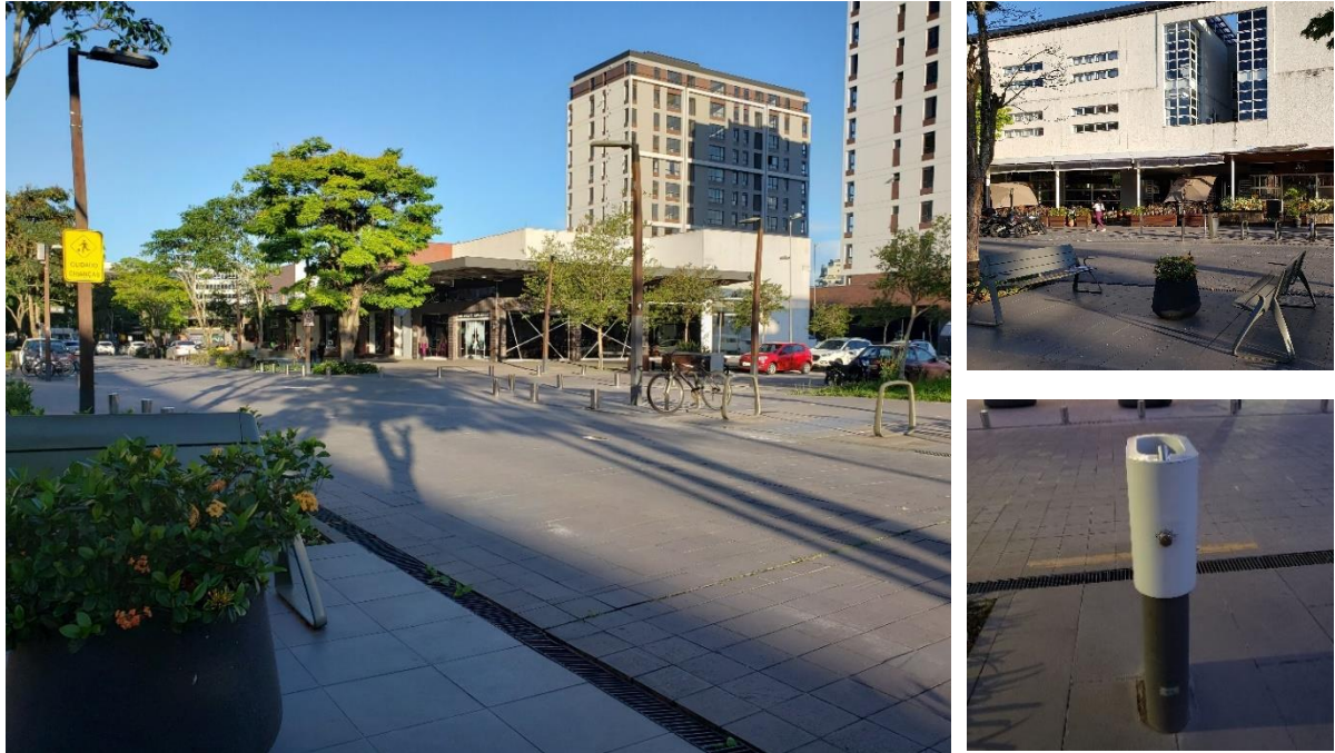
Figura 39: Destaque para a materialidade e mobiliário instalado ao longo do Passeio Pedra Branca
