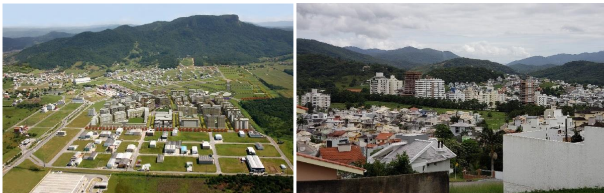
Figura 40: Mosaico com (a) imagem de divulgação do empreendimento com a nova centralidade proposta e (b) vista parcial da área residencial com vazios existentes e barreiras naturais.
