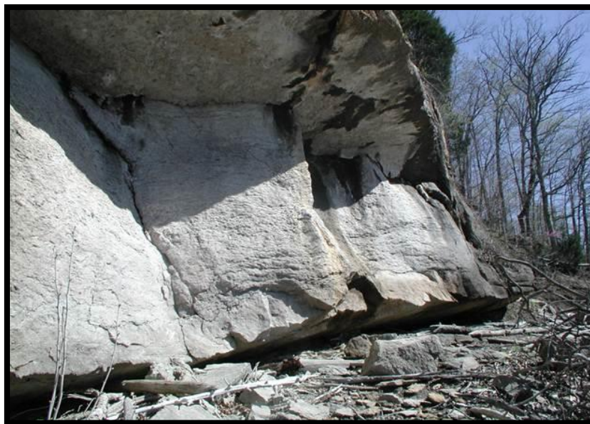
Figura 5. Estrutura maciça em calcário.
