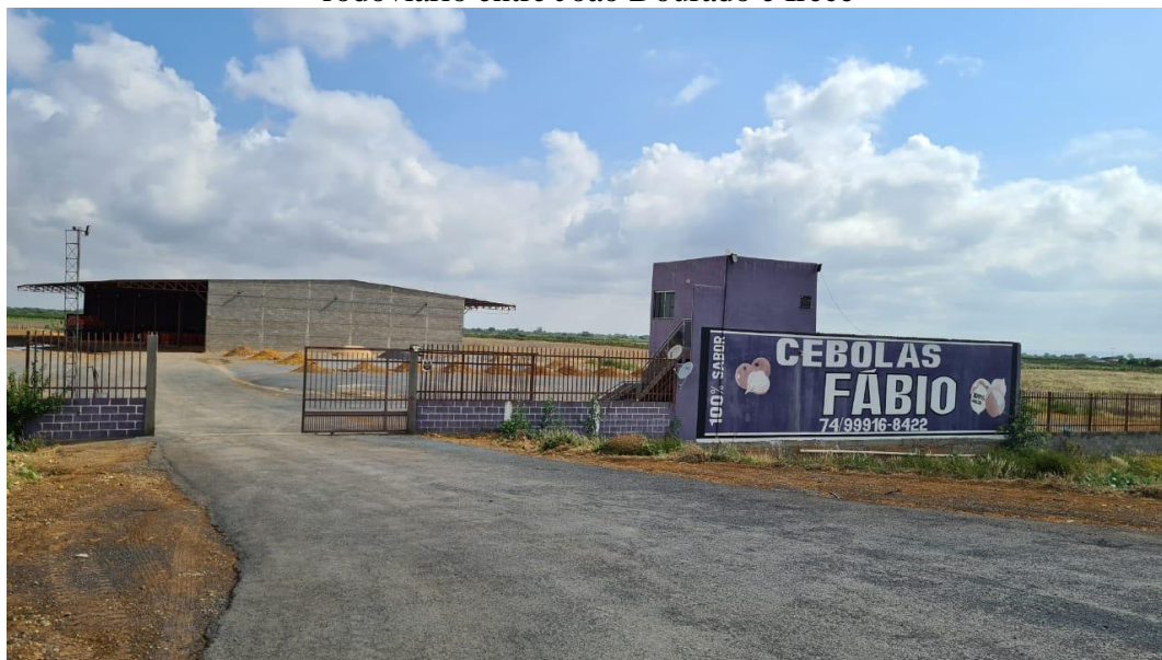
Imagem 11 - Unidade de armazenamento e beneficiamento da cebola, no entroncamento rodoviário entre João Dourado e Irecê
