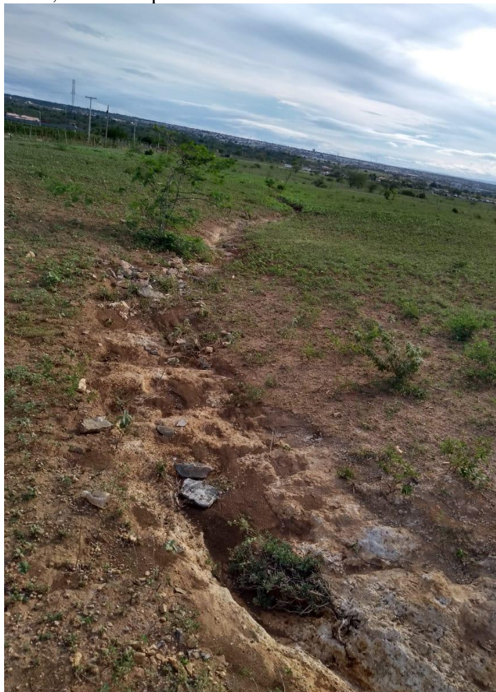
Imagem 9 - Processo de ravinamento, localizado em uma propriedade no povoado de Mocozeiro, no município de Irecê - área com declividade moderada
