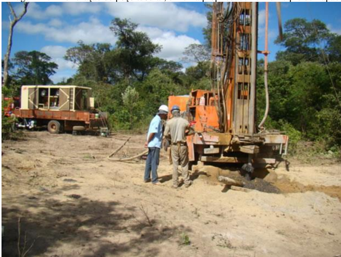
Imagem 17 - Perfuração de poço tubular, em uma propriedade no município de Lapão
