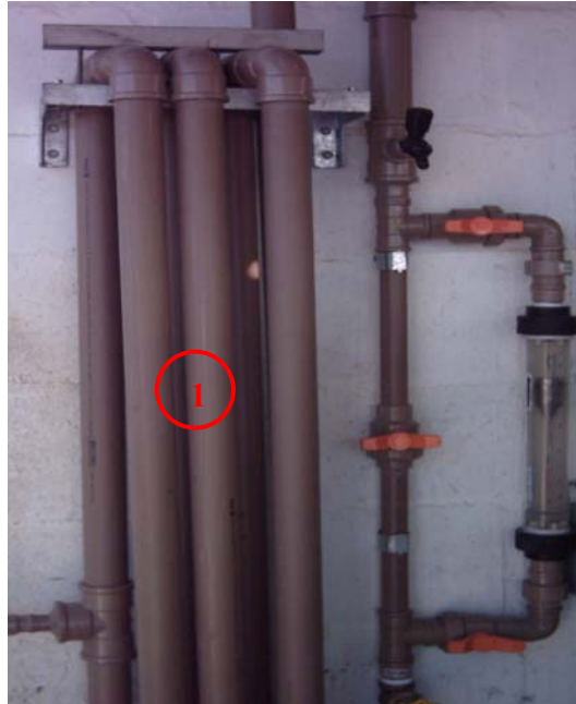
Figura 13. Fotografia do reator FF ® em operação na empresa Viamão Ltda. (DN 50mm - capacidade de tratamento de 7m 3 .h -1 ). 1 – FF.
