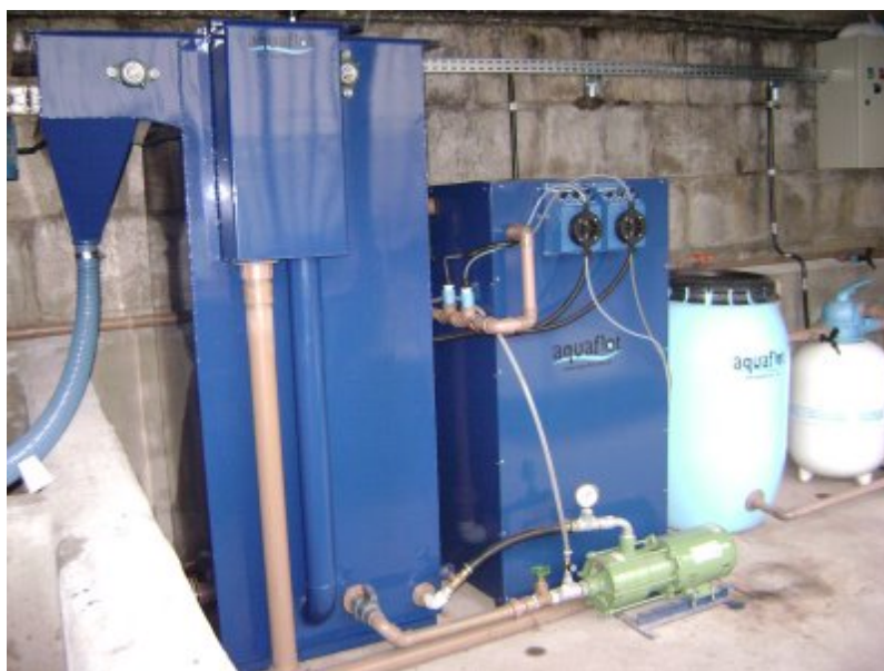
Figura 1. Fotografia de uma ETAR instalada em uma empresa de ônibus (capacidade de tratamento de 2.500L.h -1 ).
