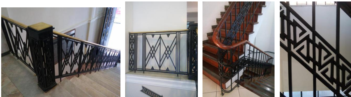
Edifício Bastian Pinto Detalhes guarda-corpos e corrimãos | Fotos por Caroline Hädrich 2018
