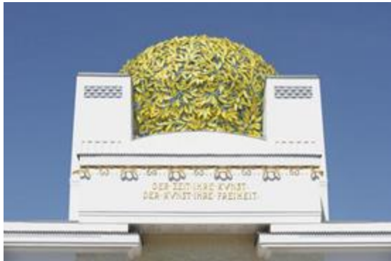
Detalhe da fachada do edifício Secessão
