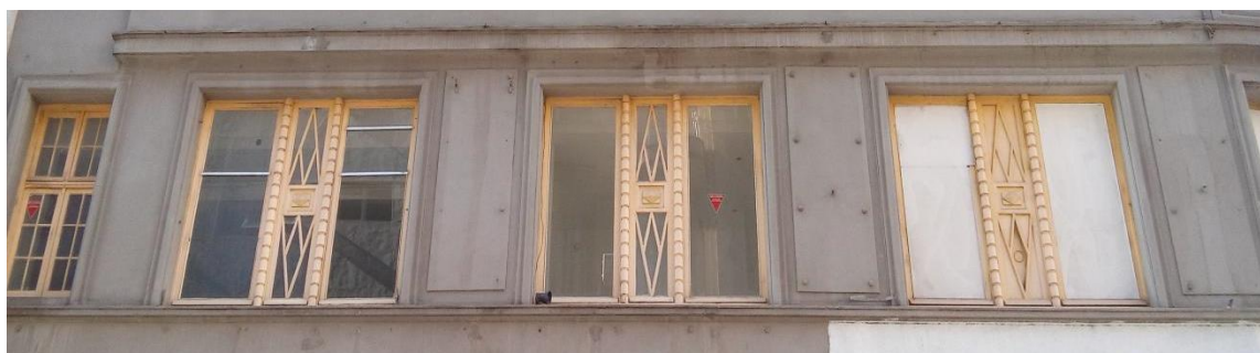
Edifício Bastian Pinto Detalhe fachada Fotos por Caroline Hädrich 2018
