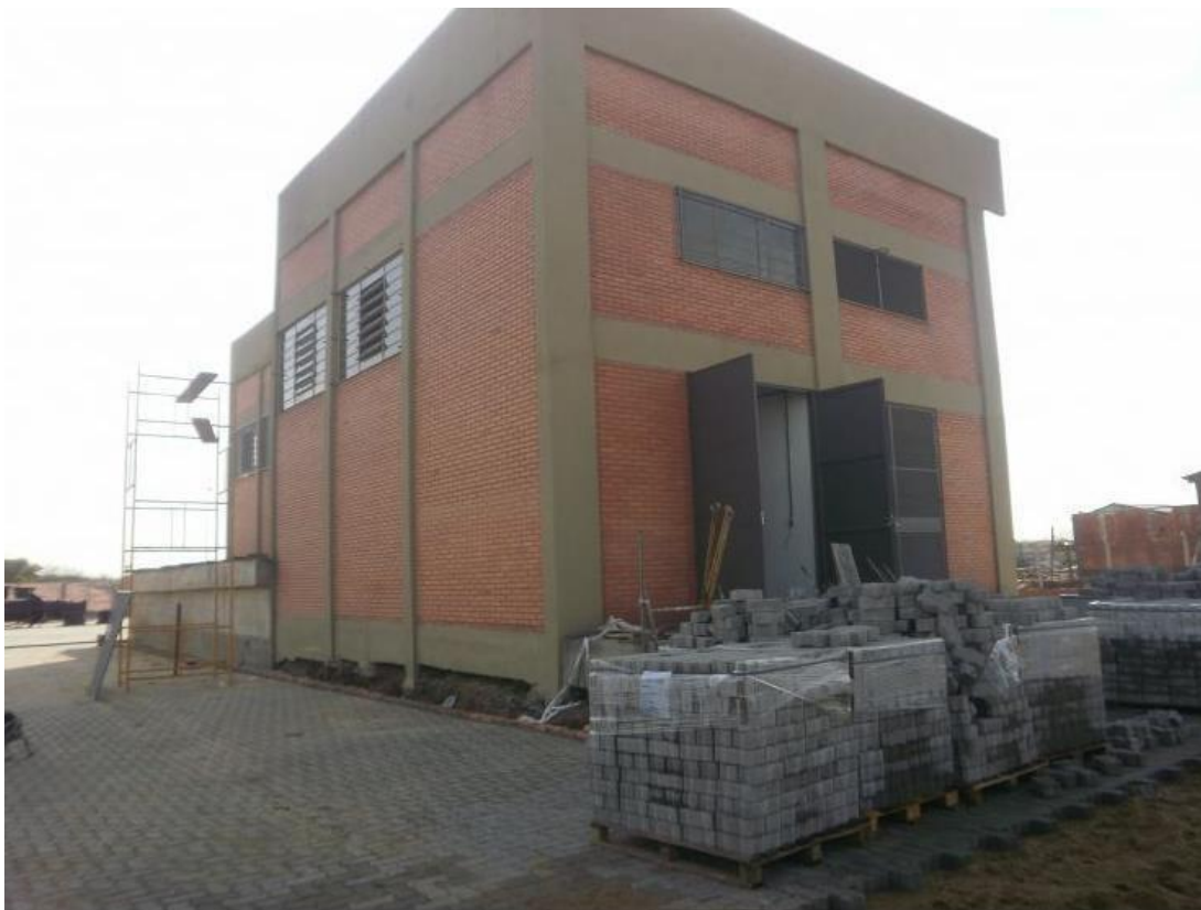
Figura 16 - Obra de macrodrenagem da Vila Minuano. Fonte: http://www2.portoalegre.rs.gov.br/dep/default.php?p_secao=92
