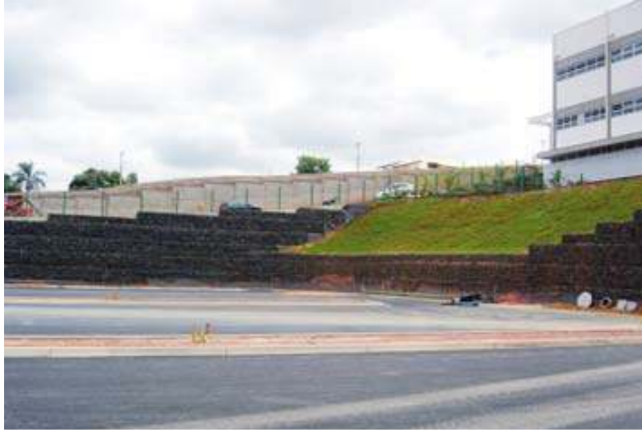
Figura 12: após a construção do muro de solo reforçado Terramesh® System (MACCAFERRI AMÉRICA LATINA, 2009a)
