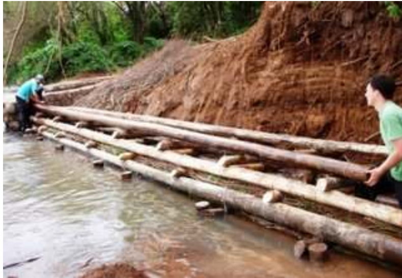
Figura 10: construção da parede vegetada complementada por feixes vivos (SUTILI, 2007)
