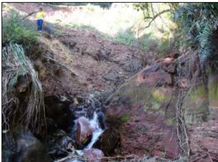
Figura 14: vista geral da ruptura, de jusante para montante (trabalho não publicado 27 )
