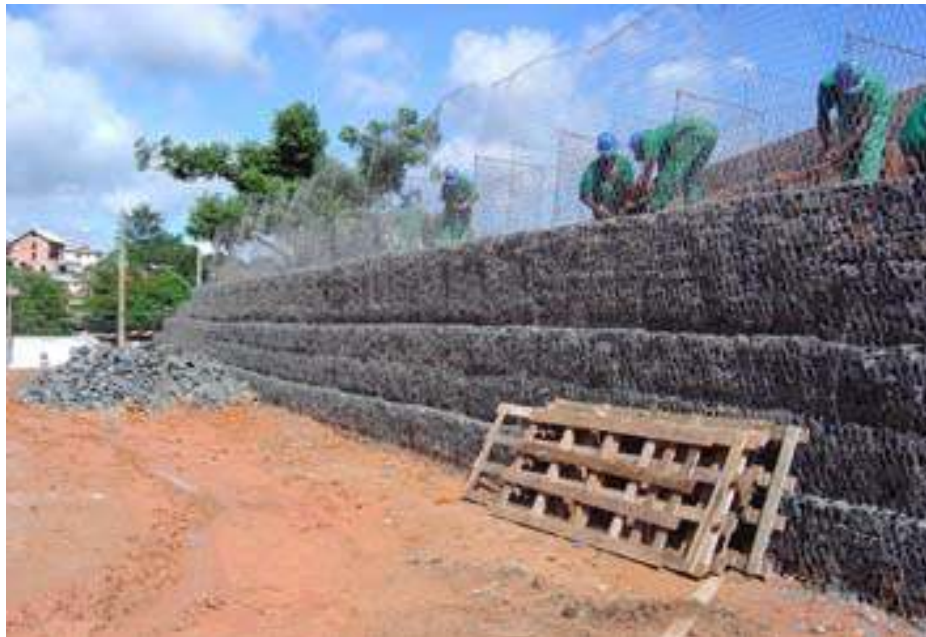
Figura 11: aplicação de um muro de solo reforçado Terramesh® System (MACCAFERRI AMÉRICA LATINA, 2009a)
