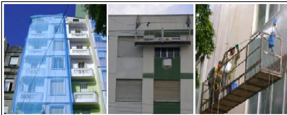
Figura 7: edifícios utilizando redes de proteção e andaime suspenso
