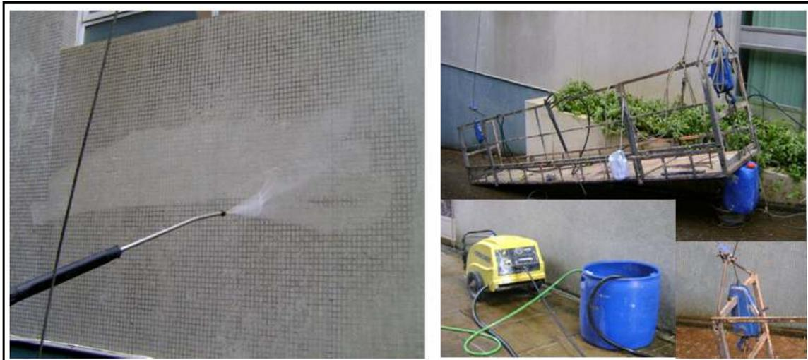
Figura 9: execução da limpeza com água sob pressão e equipamentos utilizados
