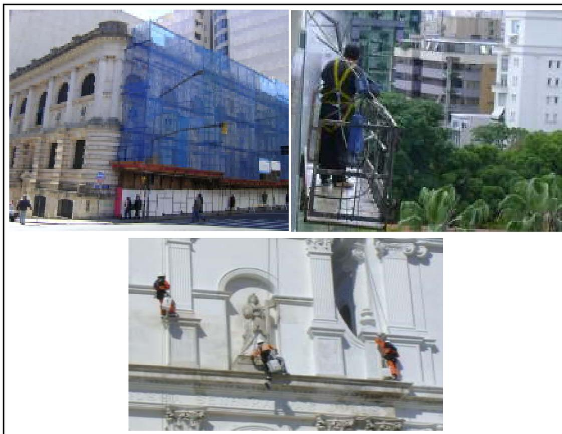
Figura 6: utilização de equipamentos de proteção adequados às fachadas
