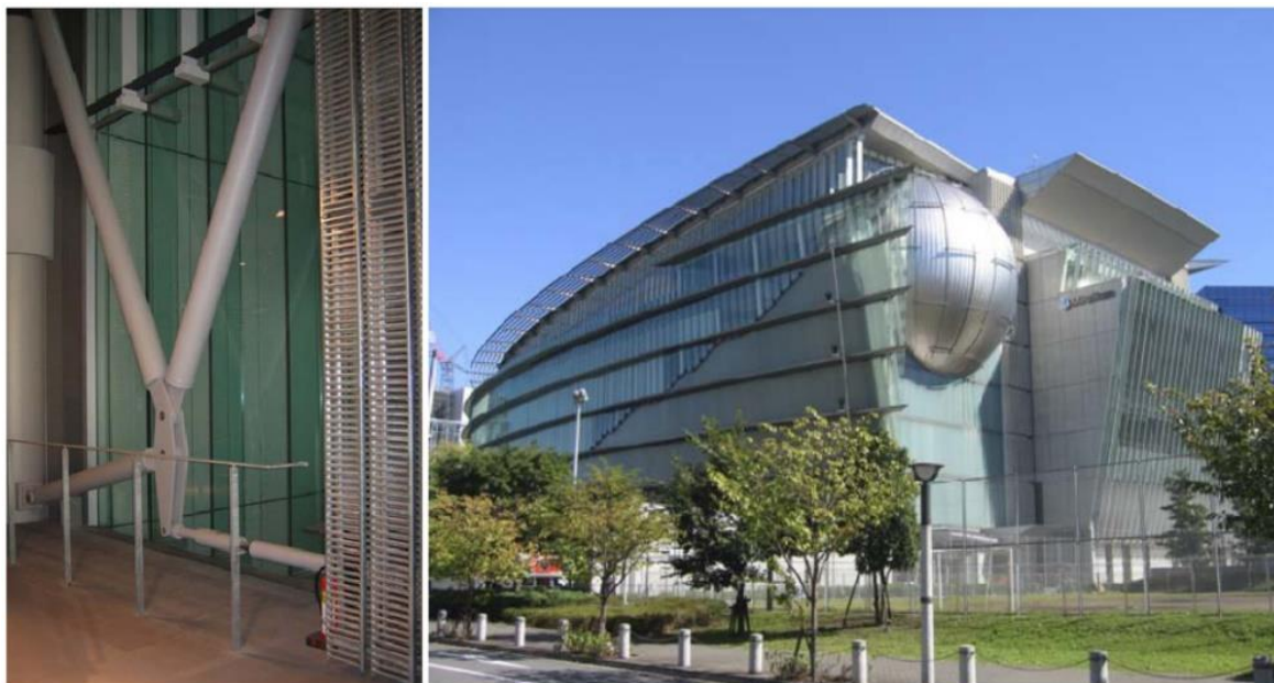
Figura 2.11 – Edifício Nihon-Kagaku-Miraikan, com amortecedores MR (BITARAF, 2011).
