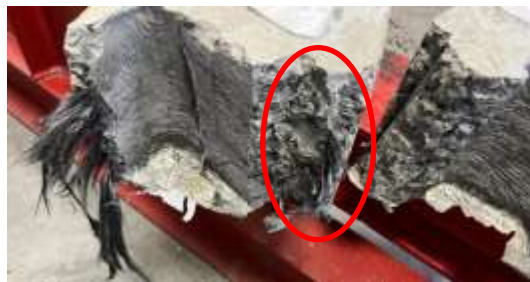
Fig. 20. Fibra rompida na estrutura da viga.
