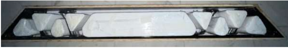
Fig. 18. Forma da viga concluída.
