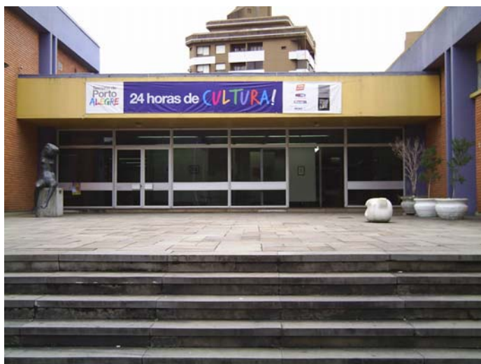
Fotografia 2 – Fachada do Centro Municipal de Cultura
