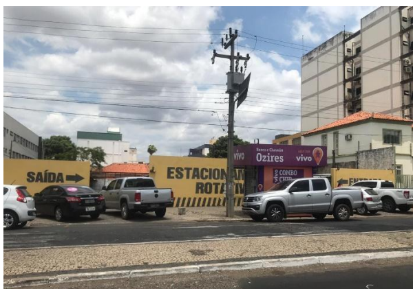
Figura 33: Fachada do estacionamento onde se encontrava a antiga Casa Antonino Freire.
