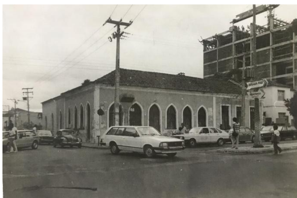
Figura 32: Fachada da Casa Antonino Freire.
