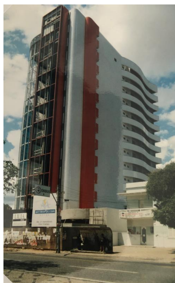
Figura 35: Fase de construção do hotel de luxo na Frei Serafim.
