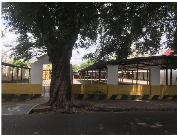
Figura 31: Fachada do estacionamento onde se localizava o antigo Colégio Prismático.
