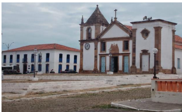
Figura 08: Fachada da Igreja Matriz de Oeiras (Nossa Senhora da Vitória).
