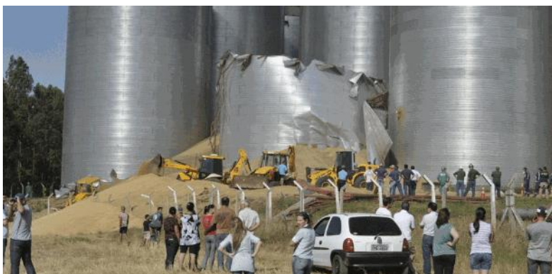
Figura 2 – Falha catastrófica em silo de armazenava soja na região sul do Brasil (NETO 2018)
