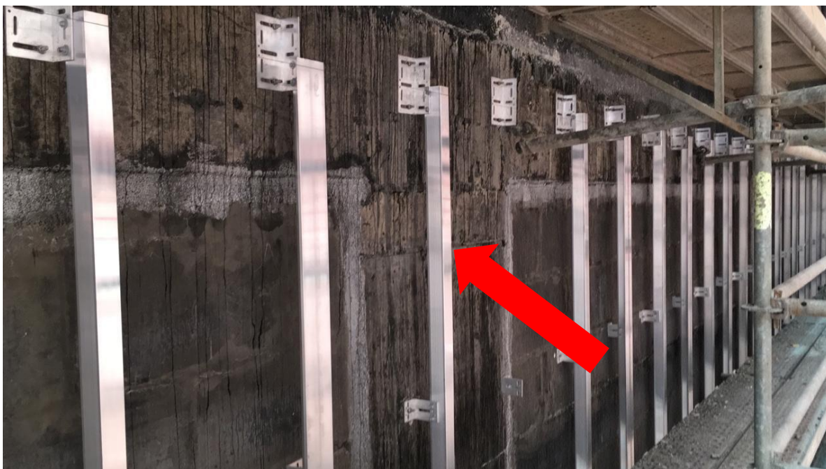
Figura 38 - Cantoneiras com perfis metálicos fixados em pavimento intermediário.
