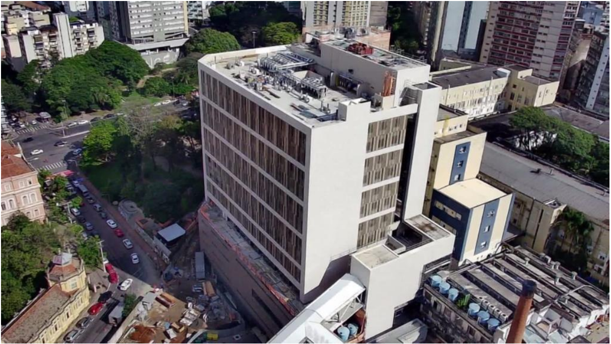
Figura 59 - Fachada ventilada (Sudeste e Nordeste) após em torno de 1 ano do início da sua execução.
