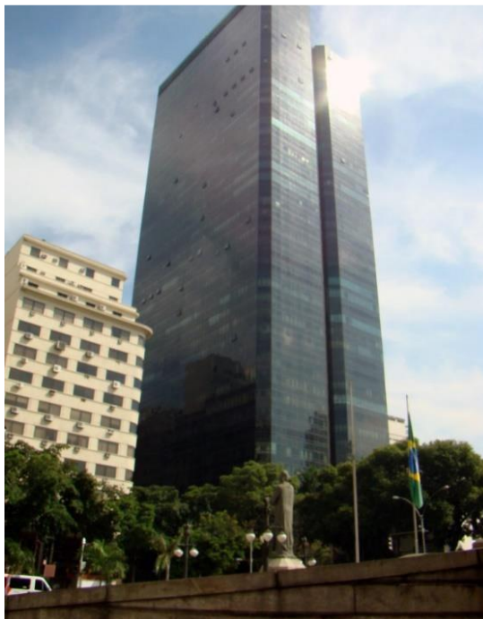
Figura 3 - Edifício Centro Cândido Mendes.
