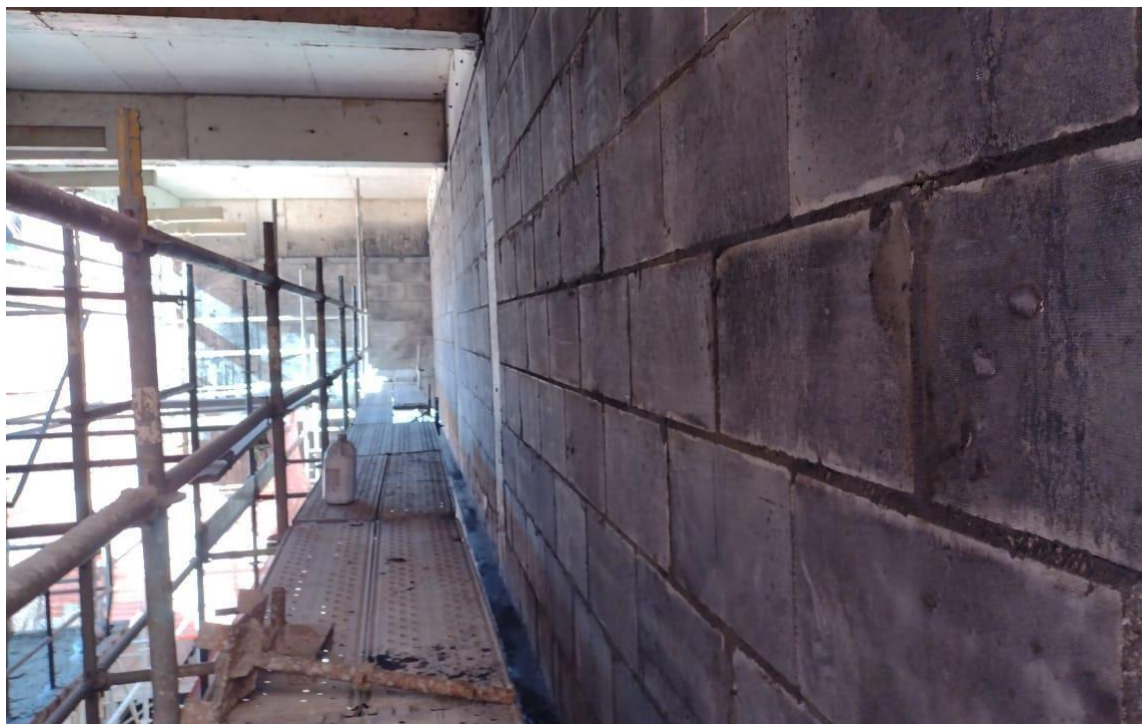
Figura 32 - Trecho da fachada impermeabilizada.
