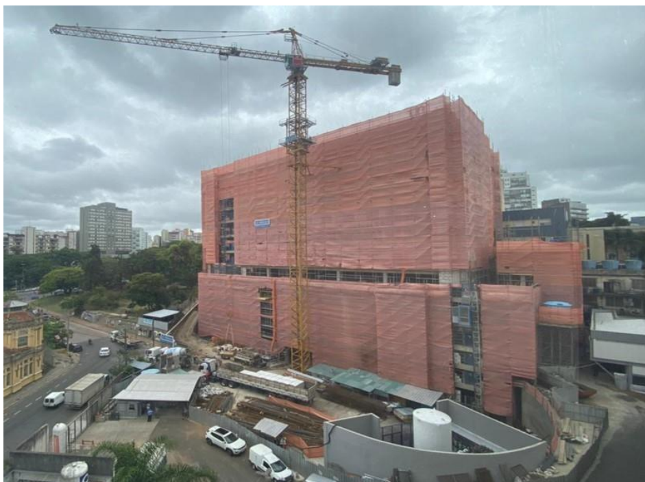
Figura 27 - Prédio com andaime fachadeiro, na imagem estão visíveis as fachadas Sudeste e Nordeste.
