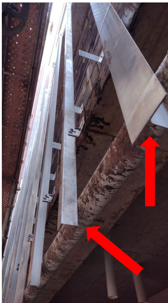
Figura 41 - Diferentes tipos de perfis fixados na fachada.
