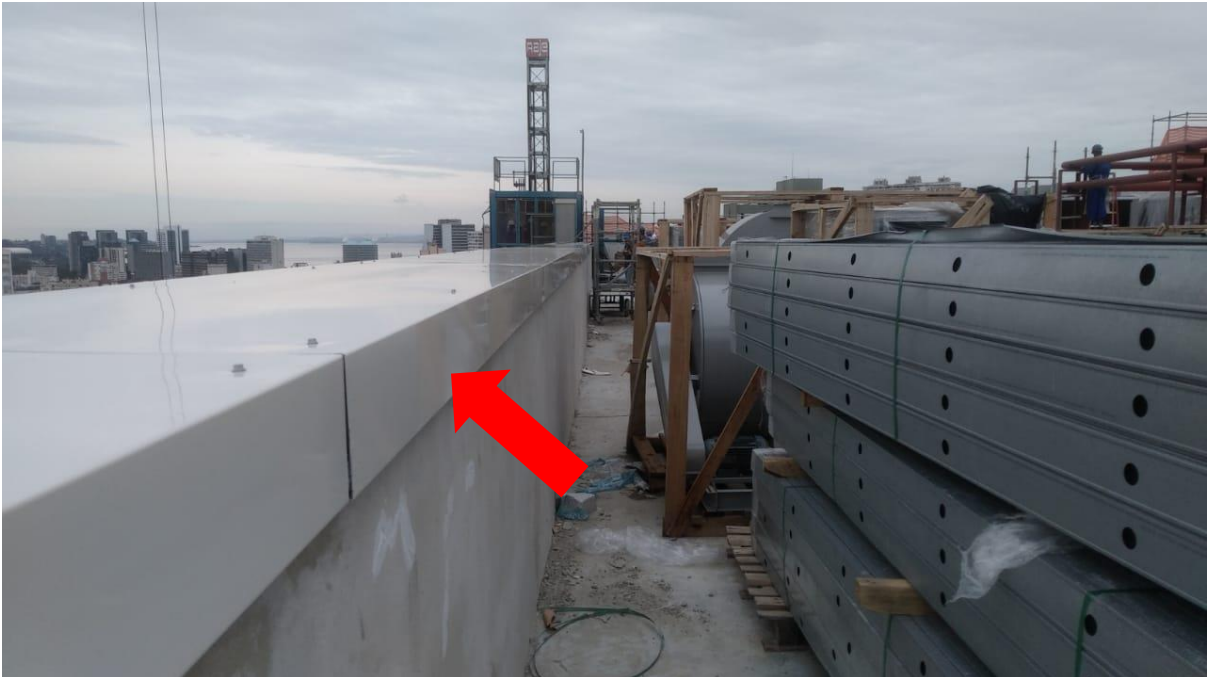
Figura 53 - Fixação dos rufos na cobertura com material em alumínio.
