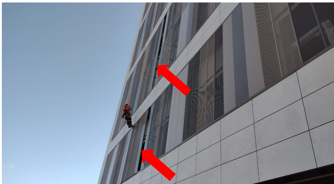
Figura 58 - Colocação de brises faltantes na fachada Sudeste.
