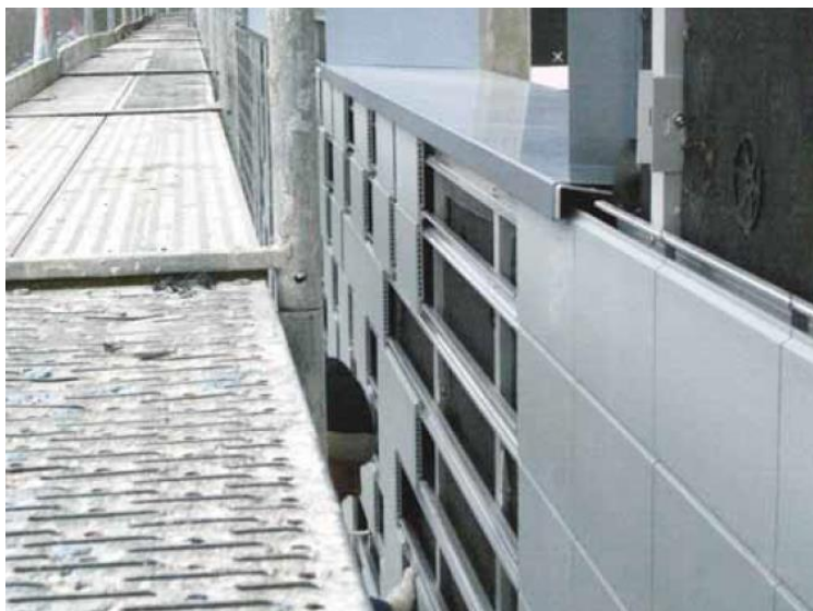
Figura 8 - Colocação das peças cerâmicas na estrutura metálica da fachada ventilada.
