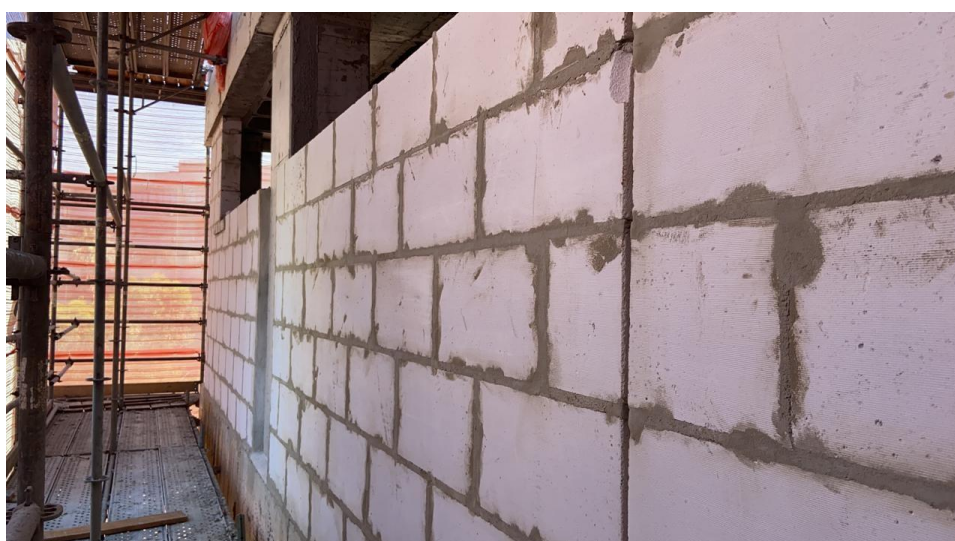
Figura 28 - Trecho da fachada com os arremates de argamassa finalizados.
