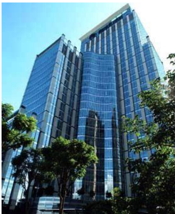
Figura 5 - Edifício Bank Boston.
