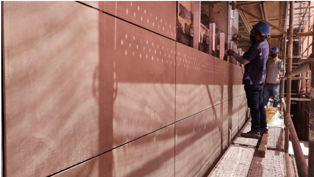
Figura 51 - Finalização da colocação do porcelanato em um trecho e execução de cortes e arremates na estrutura.
