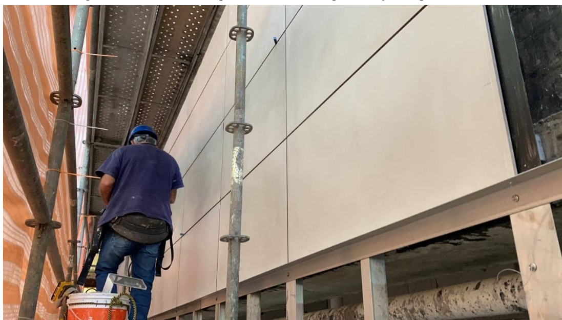
Figura 47 - Perfil inferior que serve como base para fixação do porcelanato.
