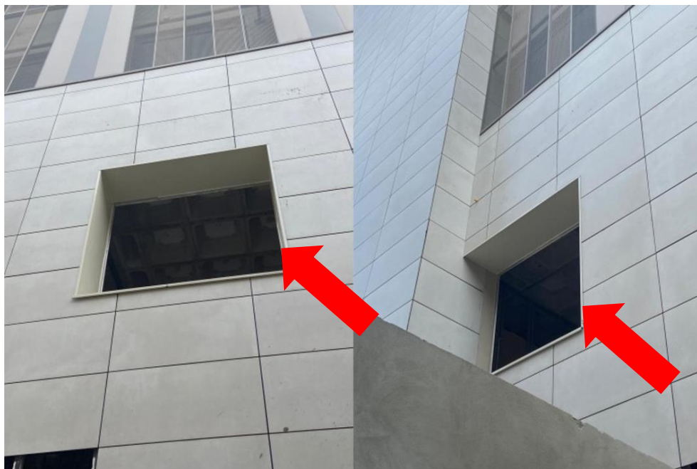
Figura 52 - Trecho da fachada Nordeste onde foram fixados os acabamentos em alumínio.
