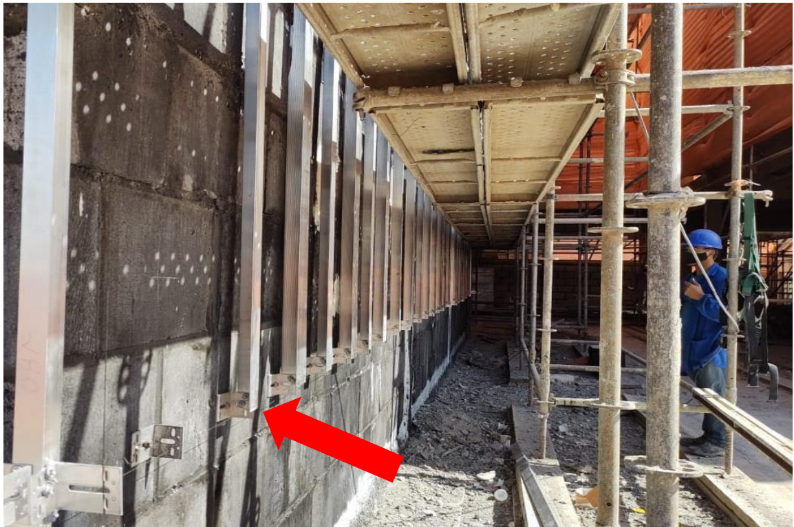
Figura 39 - Cantoneiras com perfis fixados em nível mais baixo do prédio – Térreo.
