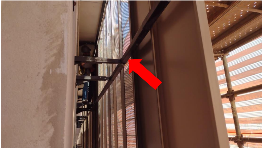
Figura 56 - Vista das estruturas auxiliares para a fixação dos brises na fachada.
