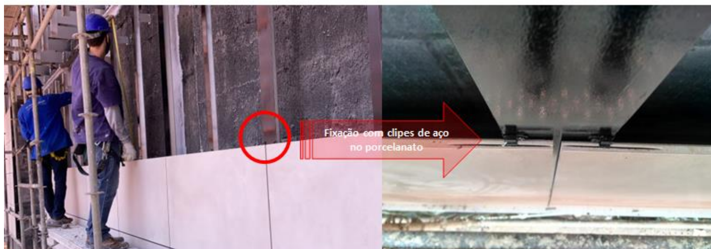
Figura 50 – Detalhe com vista superior de como a fixação é feita com o clipe de aço.
