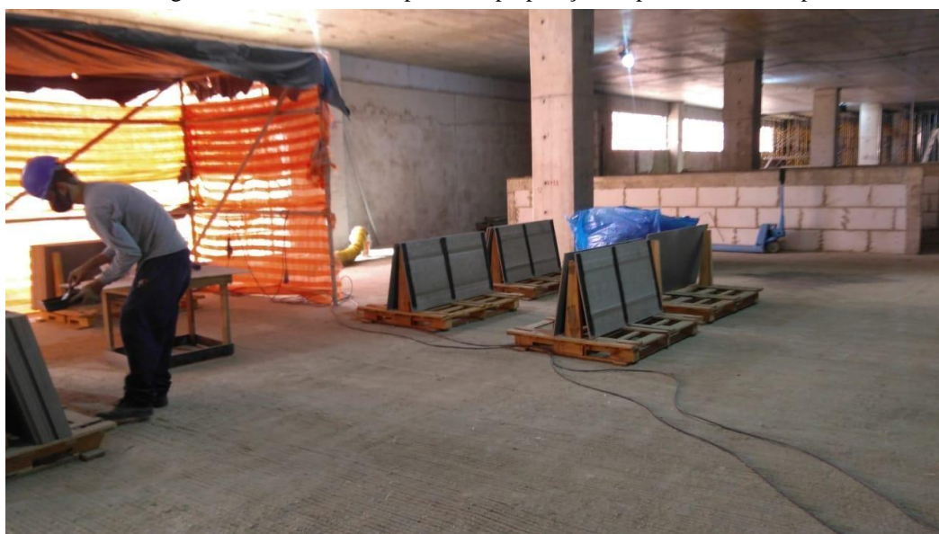
Figura 46 - Refilamento e posterior preparação do porcelanato com primer.
