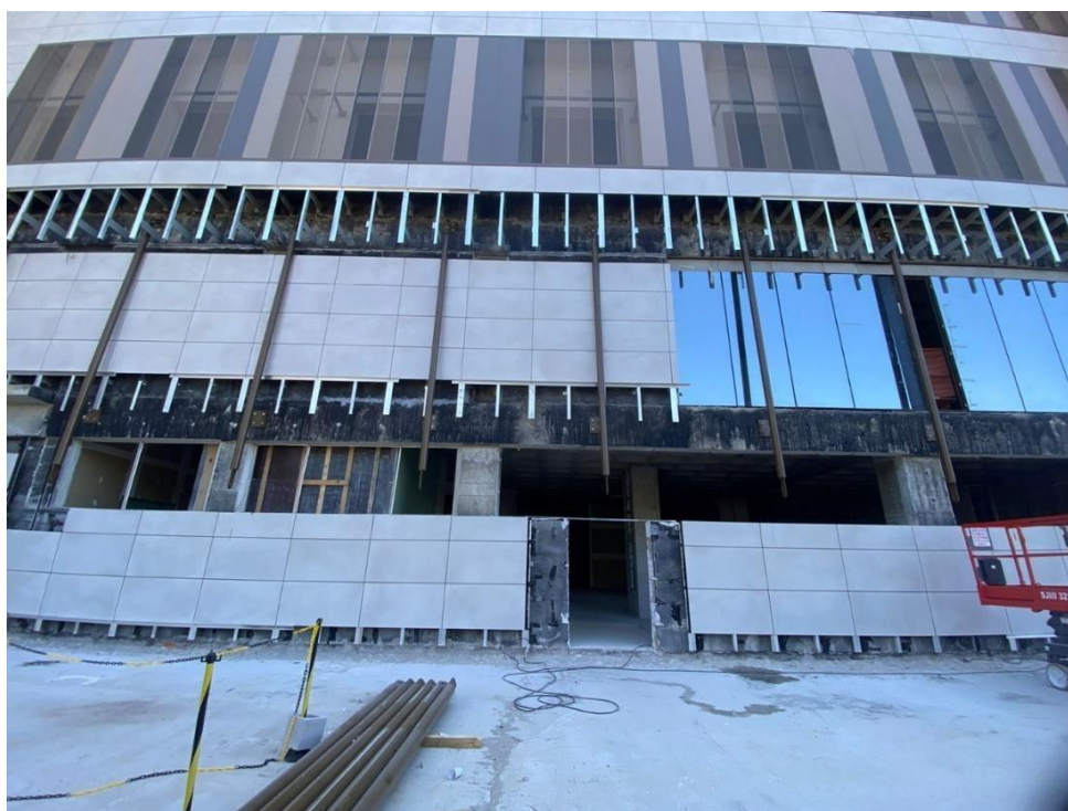
Figura 61 - Trecho da fachada Sudoeste onde a estrutura da marquise foi fixada.
