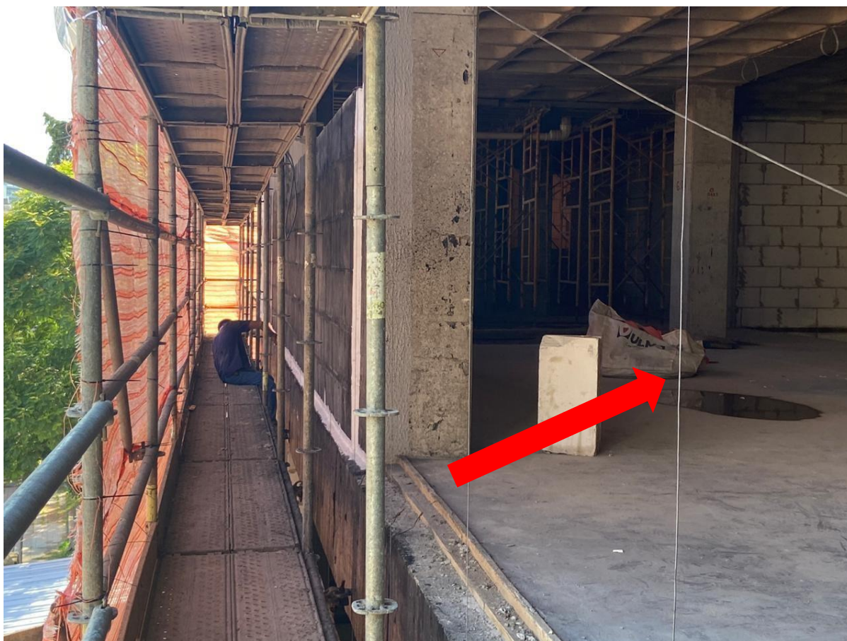
Figura 34 - Ajuste dos fios para marcar as prumadas e iniciar a fixação das cantoneiras metálicas.
