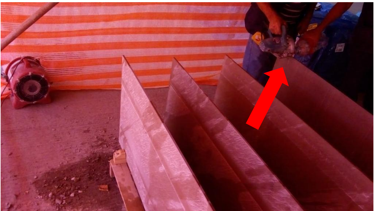
Figura 43 - Posicionamento do revestimento para refilamento e início do processo.
