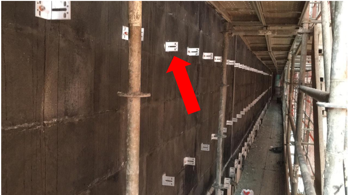
Figura 35 - Cantoneiras fixadas na alvenaria de vedação.
