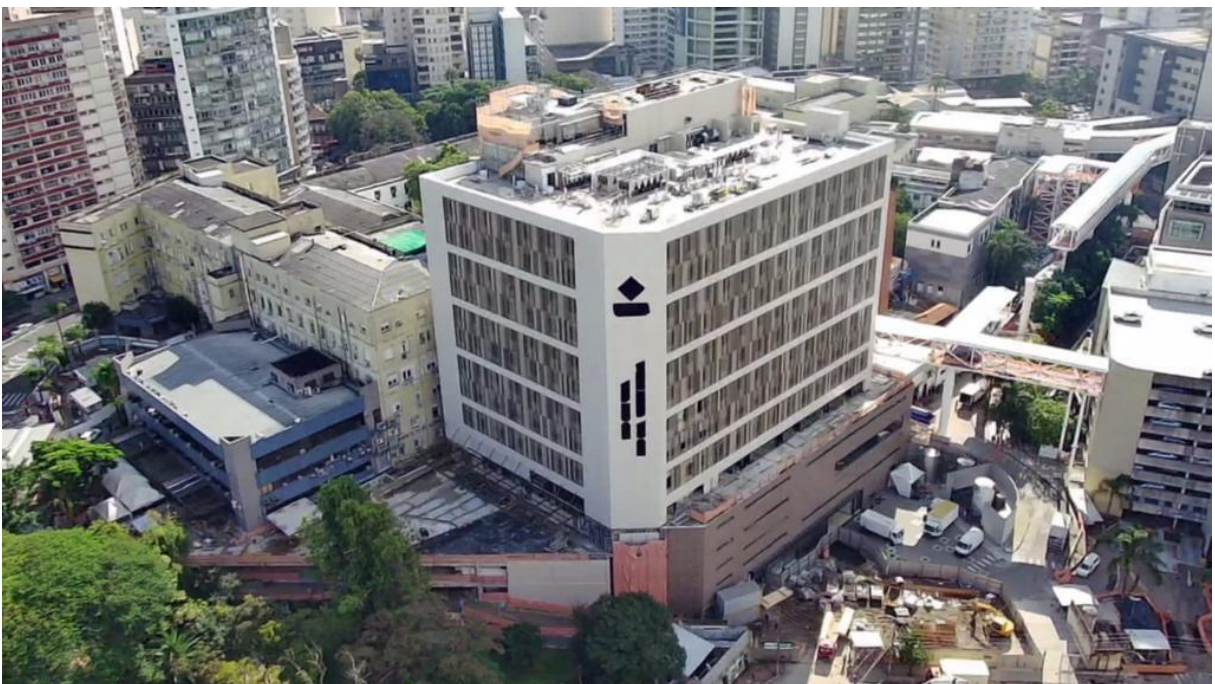
Figura 60 - Fachada ventilada (Sudeste e Sudoeste) após em torno de 1 ano do início da sua execução.
