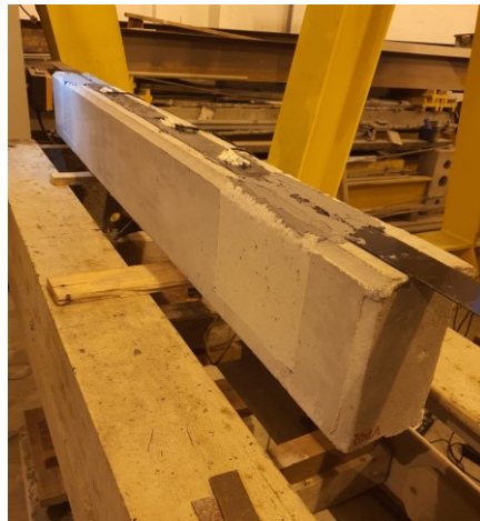
Figura 3.20 – Aplicação do laminado na viga anteriormente a protensão
