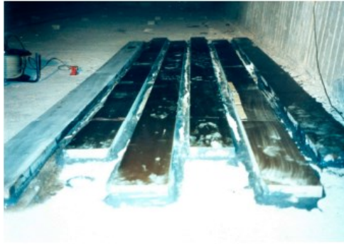
Figura 2.1 – Laminados de PRFV da ponte Kattenbusch na Alemanha durante a aplicação
