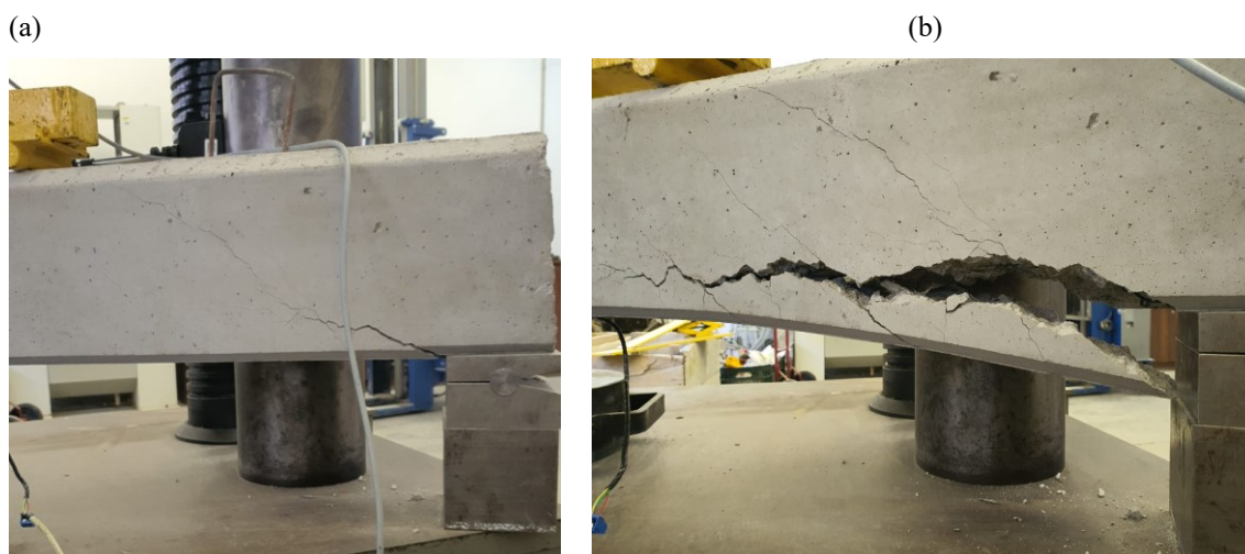
Figura 4.8 – Destacamento da cobertura de concreto juntamente com o laminado: (a) fissura inicial; (b) modo de falha
