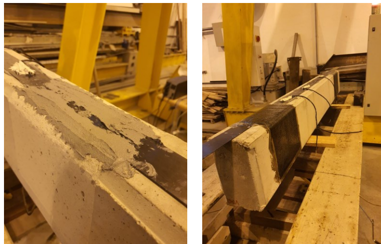
Figura 3.21 – Aplicação da ancoragem de manta com laço em U: (a) resina de nivelamento na interface entre o laminado e a manta; (b) sistema pronto para protensão
