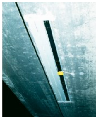
Figura 2.2 – Reforço com laminados de PRFC na ponte de Ibach na Suíça
