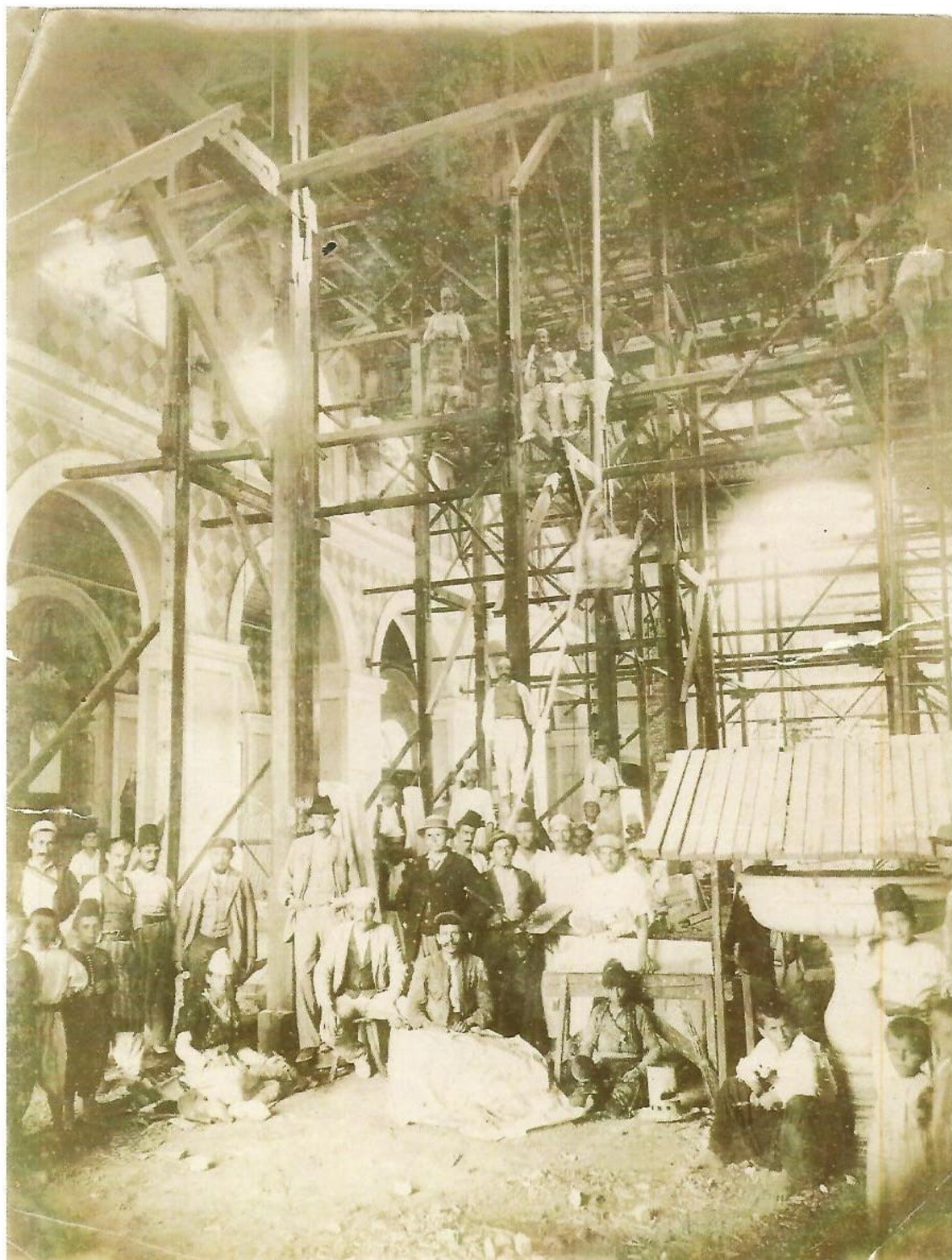
Figura 24 – Canteiro de obra da Catedral de Saravejo, s.d. Fonte: Acervo Hans Peter Gerwy.
