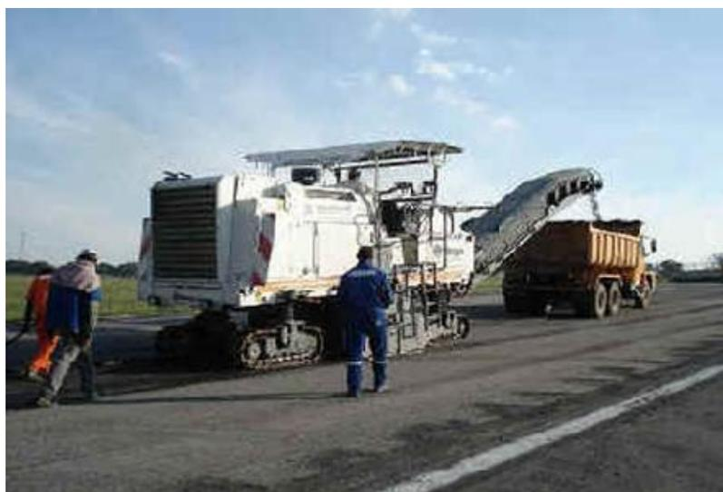
Figura 4: procedimento de fresagem de pavimentos no autódromo de Interlagos/SP (PAULIFRESA FRESAGEM E RECICLAGEM LTDA)
