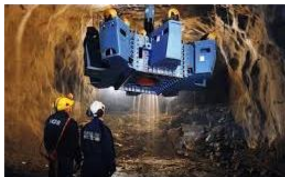
Figura 14 – Raisebord machine instalada em subsolo
