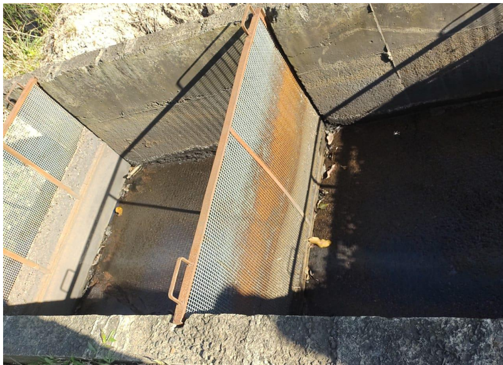
Figura 5 - Chicanas do sistema de drenagem pluvial.
