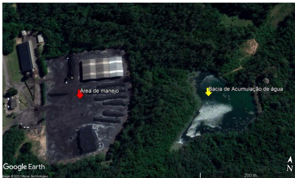
Figura 6 - Área de manejo de carvão e bacia de acumulação de água.
