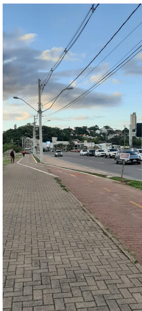
Figura 21: Trecho modificado na ciclovia da Avenida Diário de Notícias
