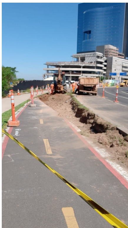
Figura 16: Obras de modificação do traçado da ciclovia no Complexo Pontal Fonte: Autora
