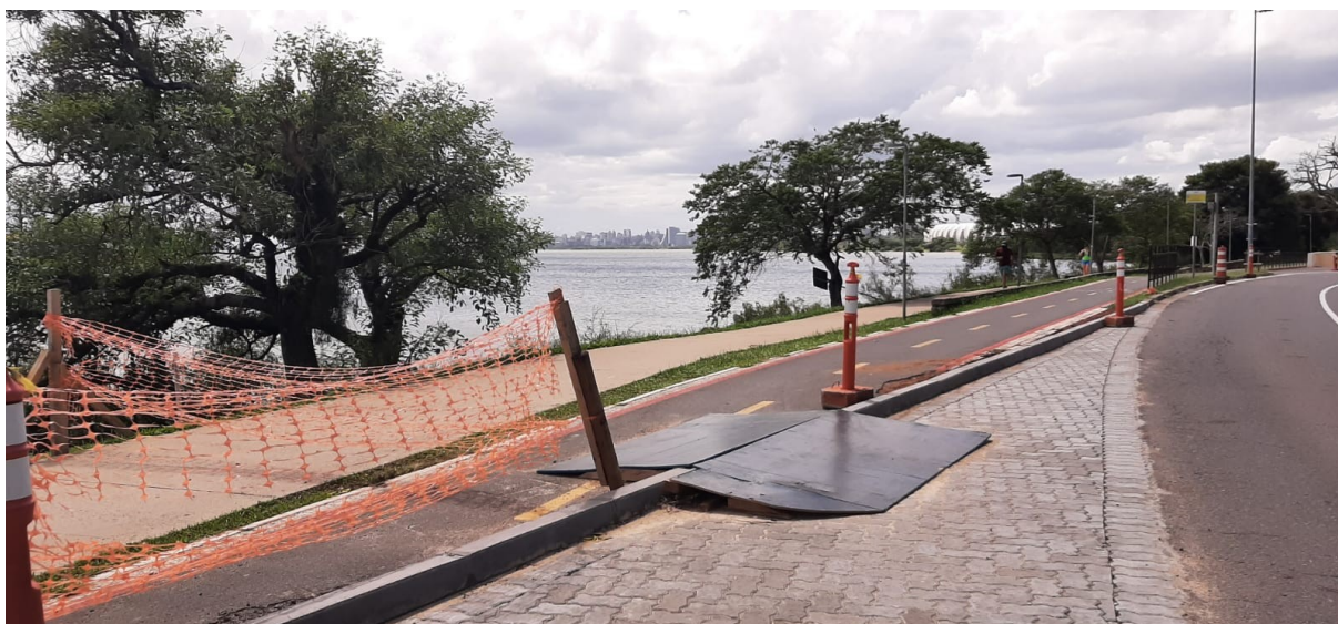
Figura 17: Rampa provisória para acessar a ciclovia
