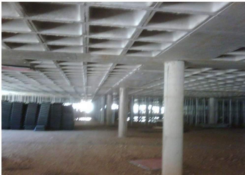
Figura 10 – Estrutura executada com vigas-faixa
