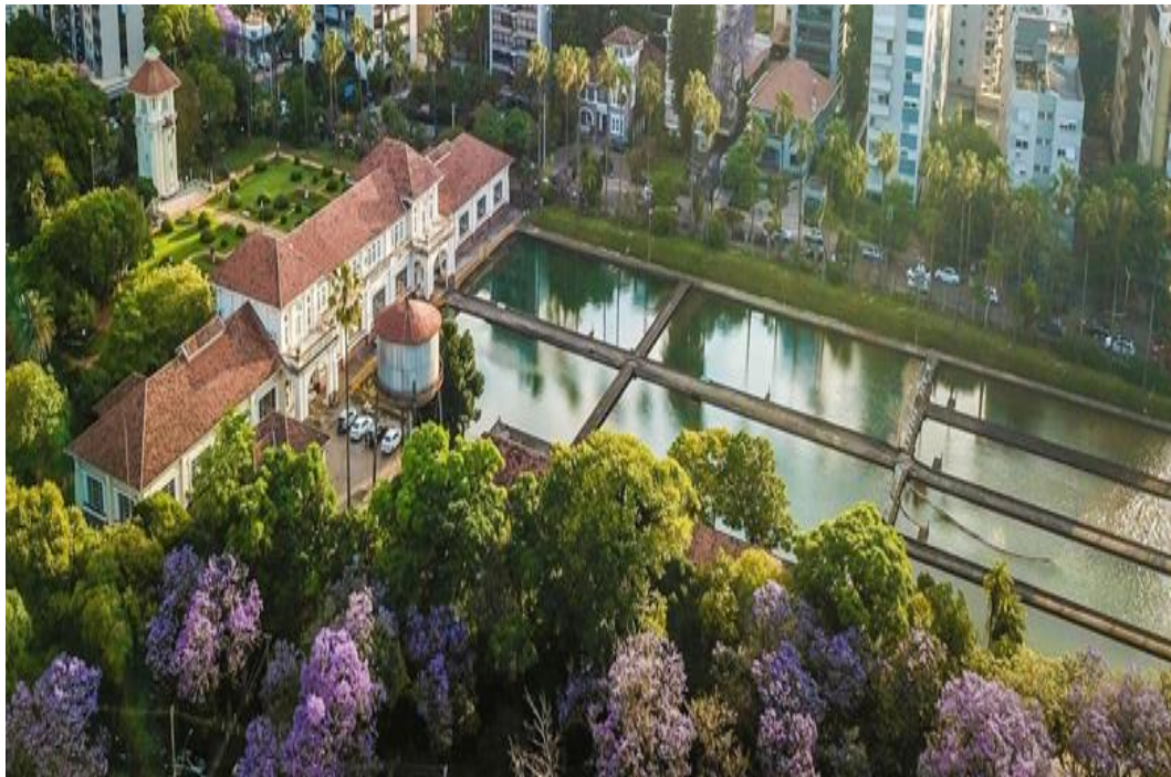
Foto 1 – Vista aérea da Estação Moinhos de Vento (DMAE)
