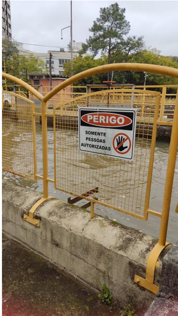
Foto 2 – Grade de proteção da Estação de Tratamento
